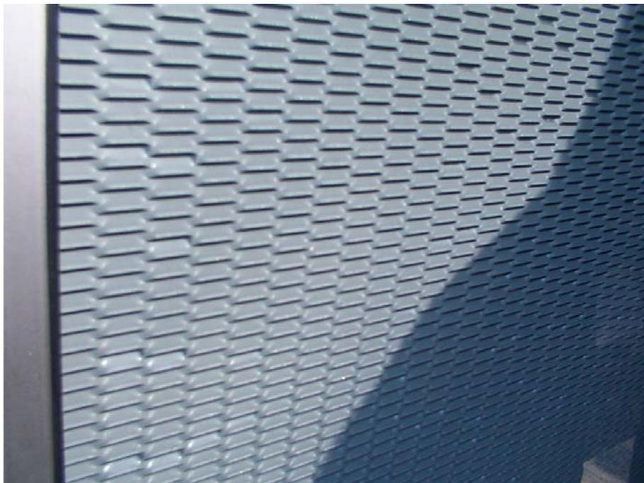
Abbildung 9: Das Sandwich-Sonnenschutzelement (Glasschild) mit eingelegtem Streckmetall in der Nahaufnahme
