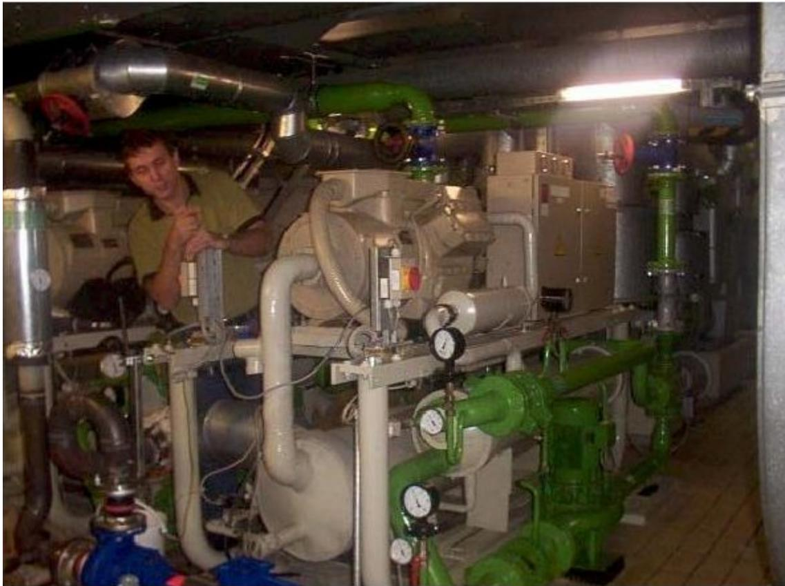
Abbildung 19: Die bestehende Kompressionskältemaschine
