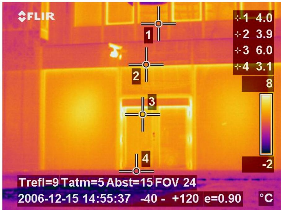
Abbildung 53: Infrarotbild der Fassade im Erdgeschoss von außen
