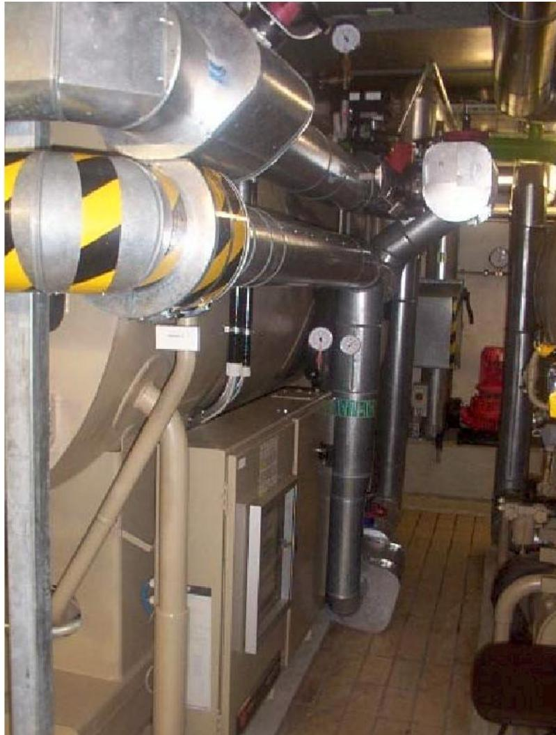
Abbildung 18: Die bestehende Absorptionskältemaschine
