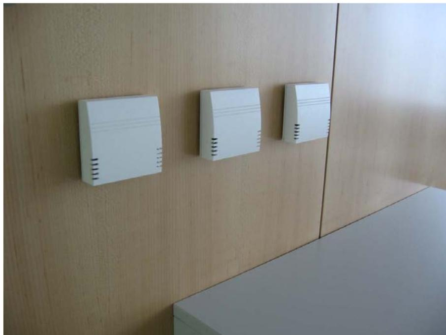
Abbildung 27: Die Sensoren im Büroraum für Feuchte, Temperatur und CO<sub>2</sub>
