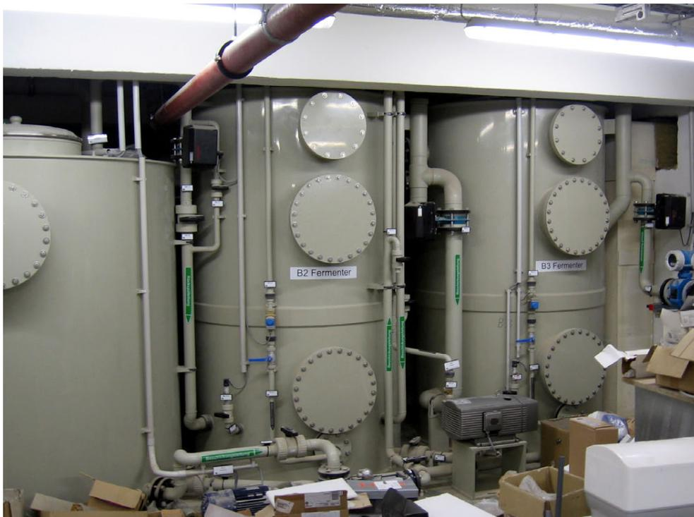
Abbildung 23: Die Fermenterbehälter der Grauwasseraufbereitungsanlage
