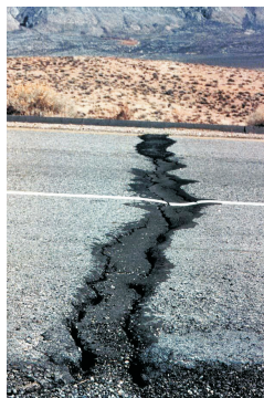
(c) Thermisch induzierte Querrisse
