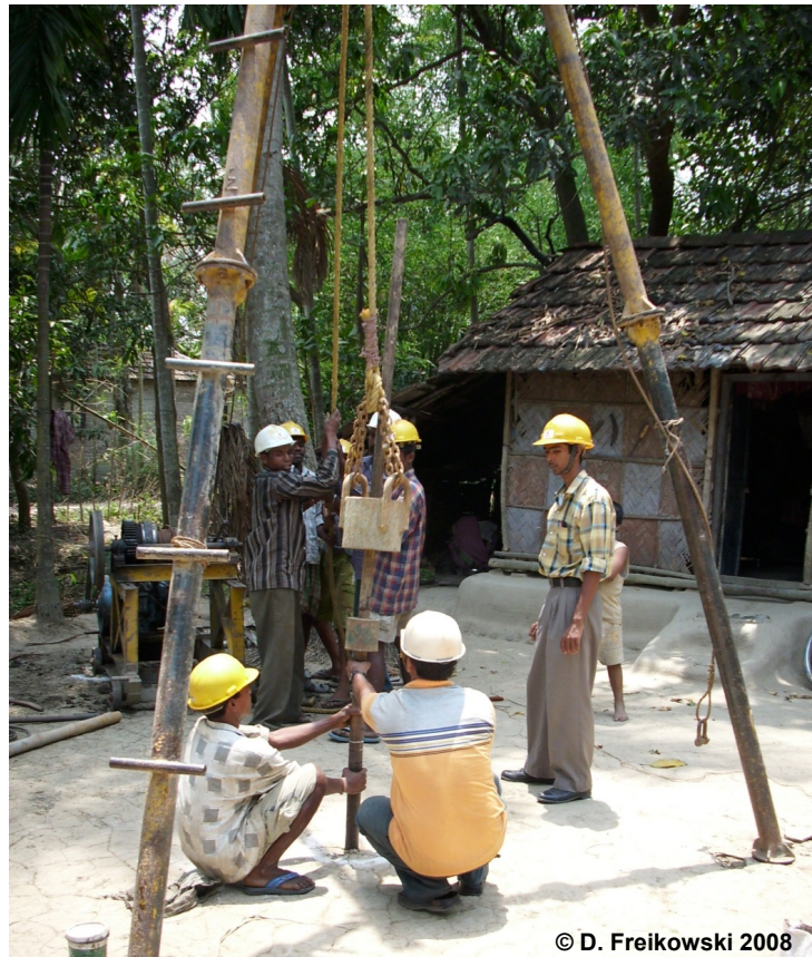
Abb. 7: Schlagbohrung zum Erhalt von Sedimentproben. Das Bohrgestänge mit den enthaltenen PVC-Röhren wurde mittels eines Gewichts (ca. 50 kg), das auf ein Gegengewicht am oberen Ende des Bohrgestänges geschlagen wurde, bis zu einer Tiefe von 12 m getrieben.
