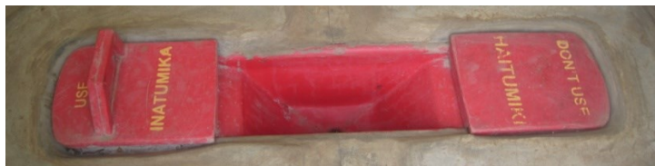
Bild 34: Separationssystem in der Trockentoilette
