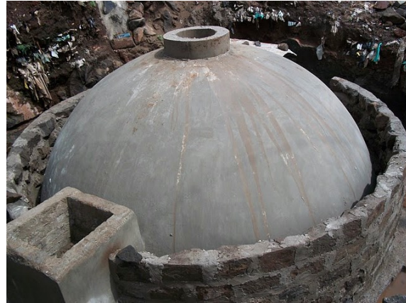
Bild 38: Biogasdome des Biogascenter im Bau
