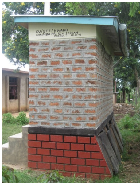
Bild 33: Trockentoilette (UDDT) mit Kompostkammer
