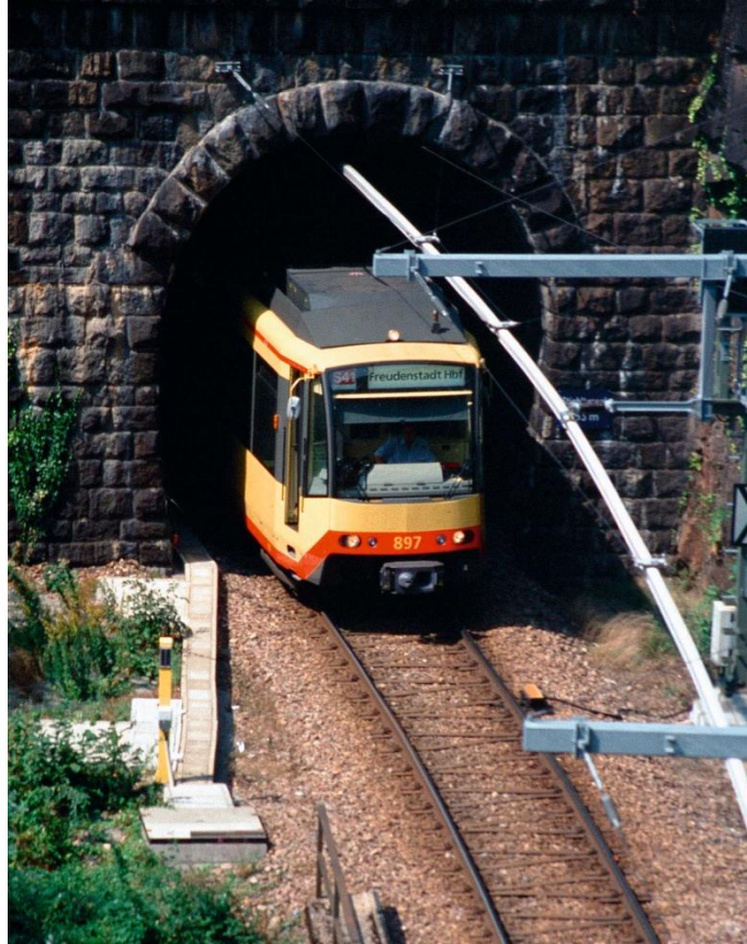
Abbildung 122: Y-Schwellen und Stromschiene am Tunnelportal des Stieltunnels im Murgtal 3047
