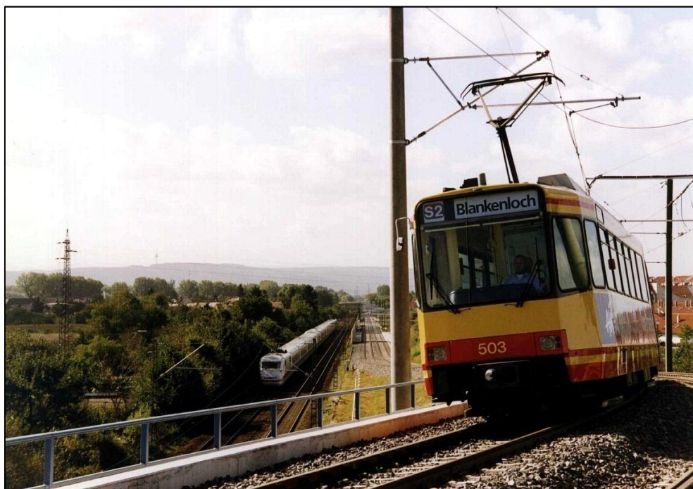
Abbildung 18: Stadtbahnbrücke über die DB-Strecke Karlsruhe – Mannheim 798
