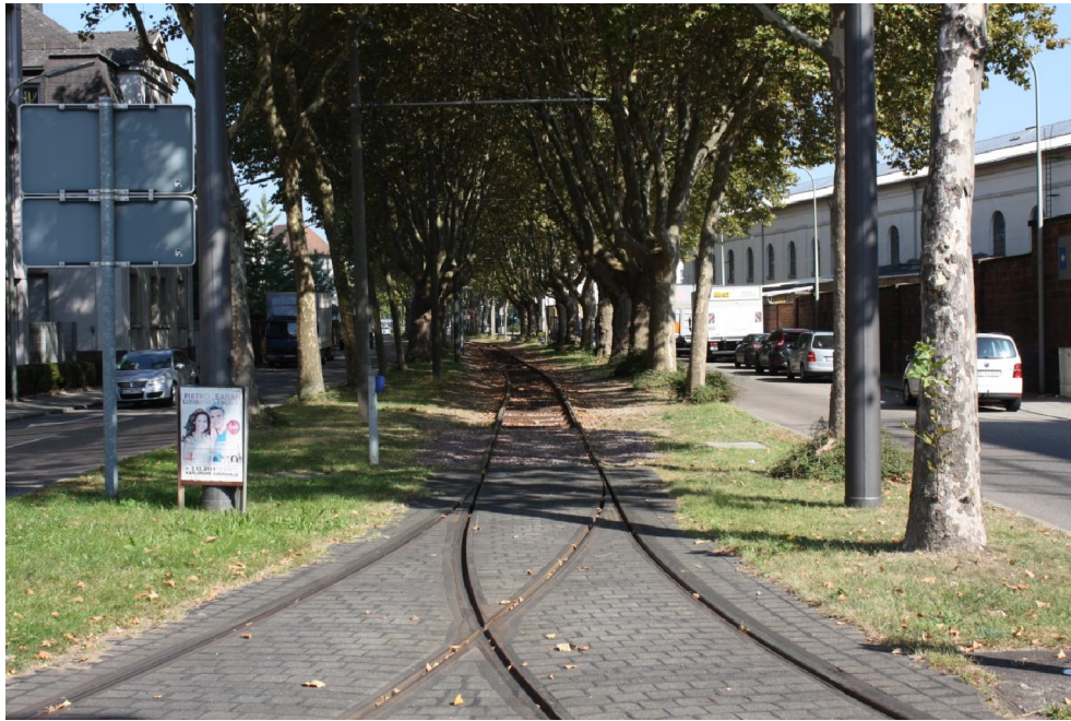
Abbildung 103: Straßenbahngleis in der Pforzheimer Straße 2400
