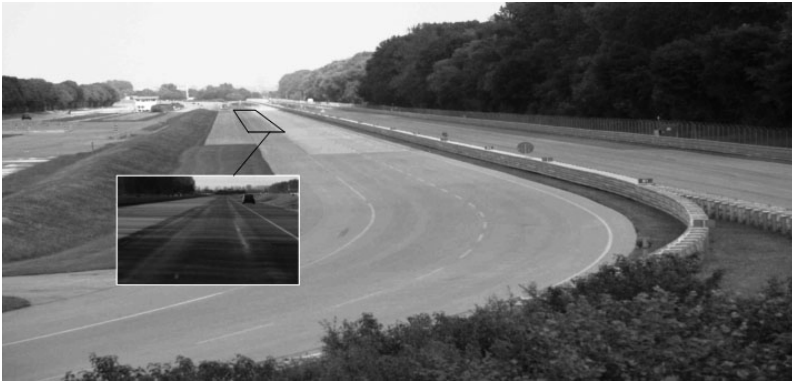
Bild 3.3.: Schnellfahrbahn Versuchsgelände Aschheim mit Spurrinnenabschnitt (Quelle: BMW Group)
