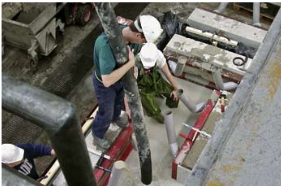
Festhalten: Baustofftechnologe beim Pumpvorgang.
