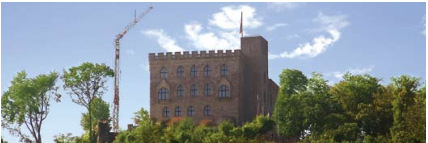
Im Zeitplan dank Lean Construction: die Renovierung des Hambacher Schlosses.
