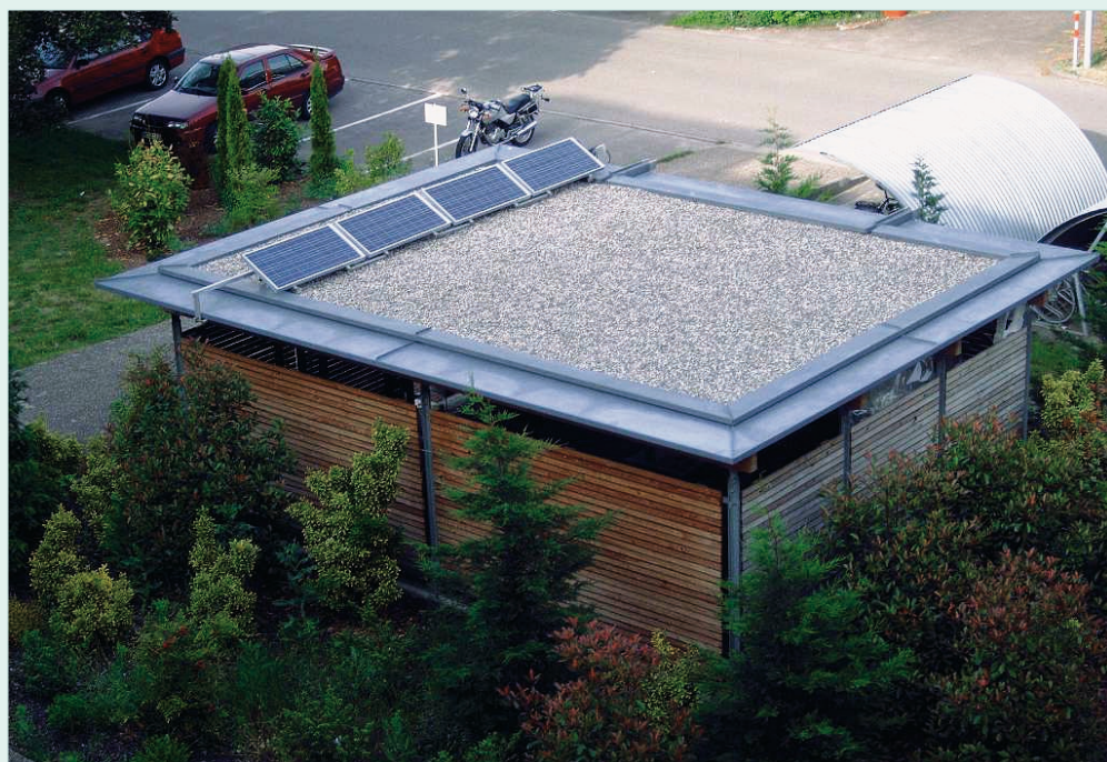
Solarzellen für die Energieversorgung der Kondensatorbankstelle.
