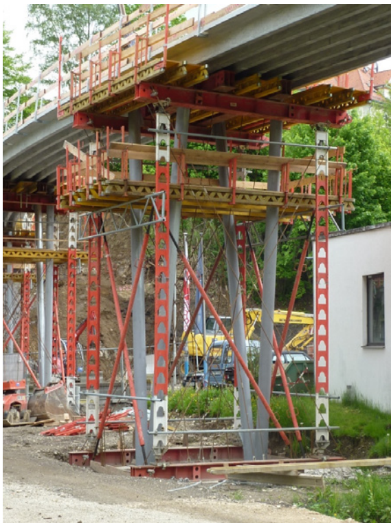
Abb. 21: Fertigteilbrücke während der Montage
