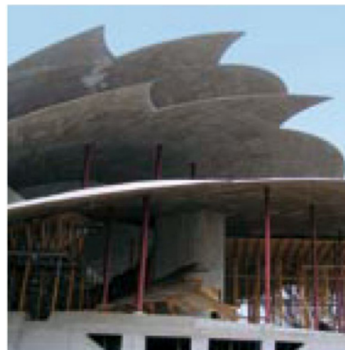
Abb. 12: Dachkonstruktion des Hans Otto Theaters in Potsdam hergestellt aus C35/45 in händischer Einbautechnik [16]
