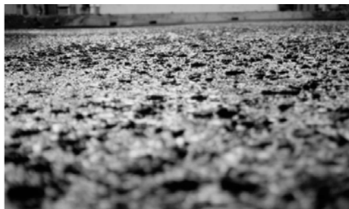
Abb. 6: Oberfläche des Brückenbauteils aus SVB 1 gemäß Tab. 1 nach dem Abziehen [11]
