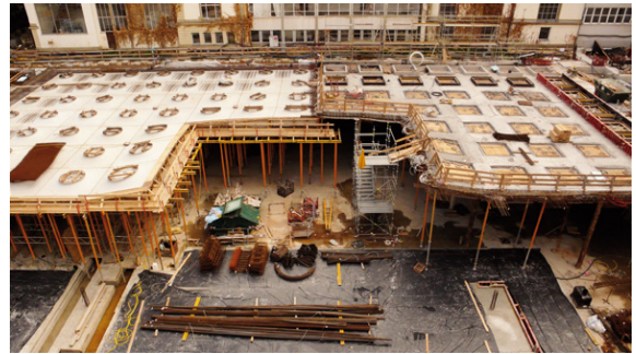
Abb. 10: Erster und zweiter Betonierabschnitt des Daches. Fotografin: Laura Padgett.
