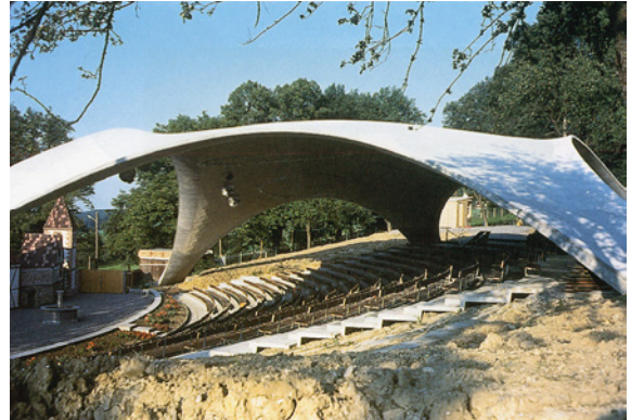
Abb. 25: Freilufttheater in Grötzingen bei Stuttgart, freigeformte Stahlbetonschale von Heinz Isler aus dem Jahre 1977, [14]
