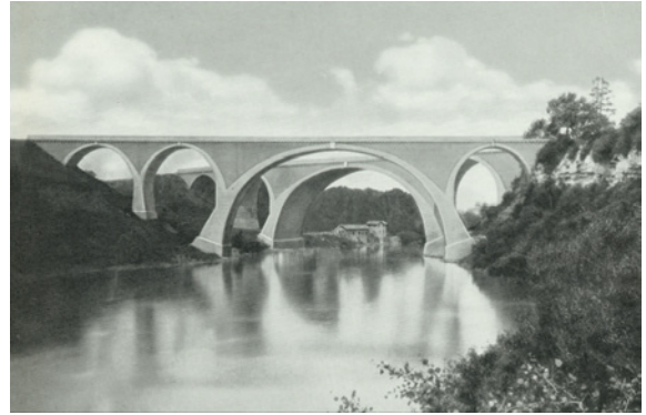
Abb. 9: Illerbrücken bei Kempten aus Stampfbeton, errichtet 1904-1906, [3]
