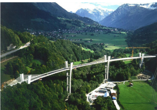
Abb. 28: Sunnibergbrücke bei Klosters von 1999, Entwurf von Christian Menn ( https://pp.auburn.edu/heinmic/concreteHistory/images/Large/ChristianMenn_Sunniberg_Bridge.jpg )
