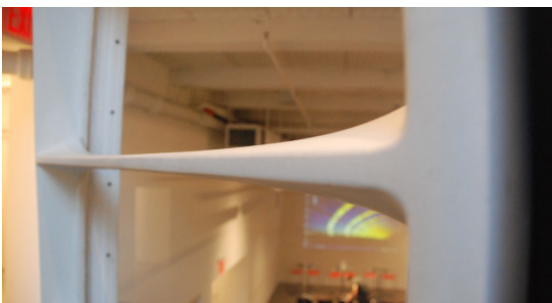
Abb. 16: Betonelemente als Fensterrahmen als Prototyp „Liquid Wall“ (Copyright: Fa. Lafarge)
