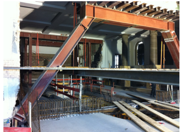
Abb. 10: Einbau A-Bock ©Bollinger + Grohmann
