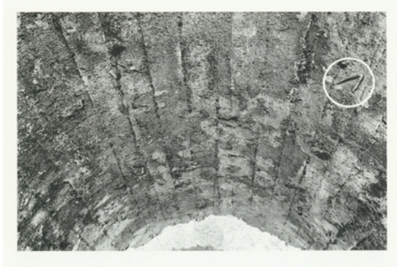
Abb. 4: Wölbung über einem Kellergang bei den Kaiserthermen in Trier, [1]
