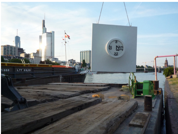
Abb. 9: Anlieferung der Schalungselemente mit dem Schiff. Fotograf: schneider+schumacher.
