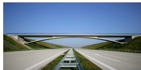
Abb. 7: Beispiel für die Herstellung eines geneigten Betonbogens aus selbstverdichtendem Beton [Tauscher2006]
