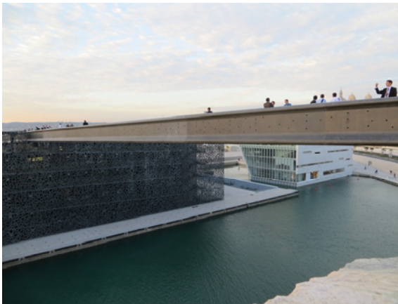
Abb. 20: Fußgängerbrücke zum „Mucem“ in Marseille (Copyright: Fa. Lafarge, Architekt: Rudy Ricciotti, Foto: Bachmann, Ed. Züblin AG)
