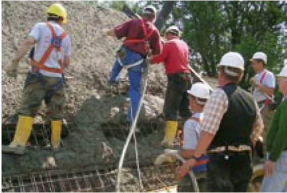
Abb. 13: Händischer Einbau eines Normalbetons C35/45 der Konsistenzklasse F2 [16]
