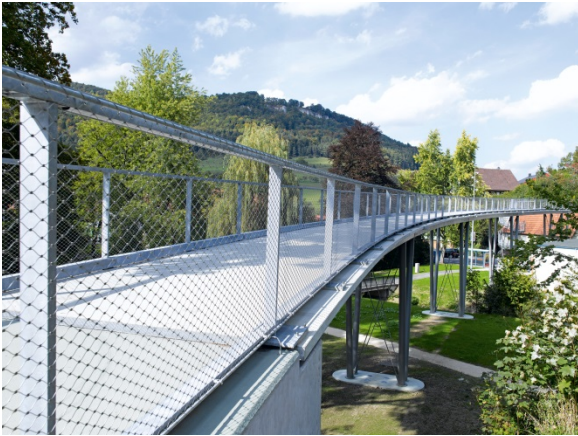
Abb. 9: Textilbetonbrücke in Albstadt-Lautlingen, aus [18]
