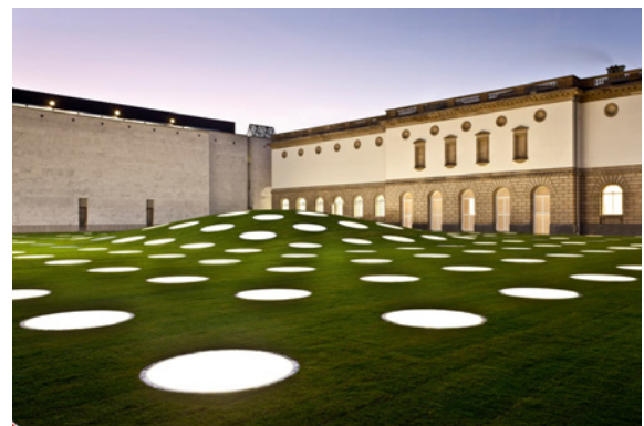
Abb. 3: Städel Erweiterung nach Fertigstellung © Norbert Miguletz
