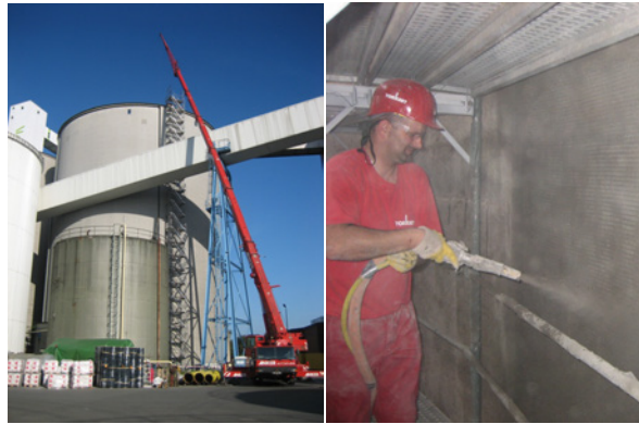
Abb. 10: Verstärkung eines Zuckersilos in Uelzen aus [20]
