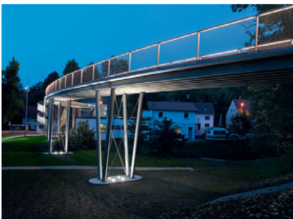
Abb. 1: Ansicht der neuen Textilbetonfußgängerbrücke in Albstadt [Foto: Groz-Beckert]
