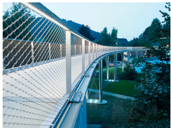
Abb. 1: Ansicht der neuen Textilbetonfußgängerbrücke in Albstadt [Foto: Groz-Beckert]
