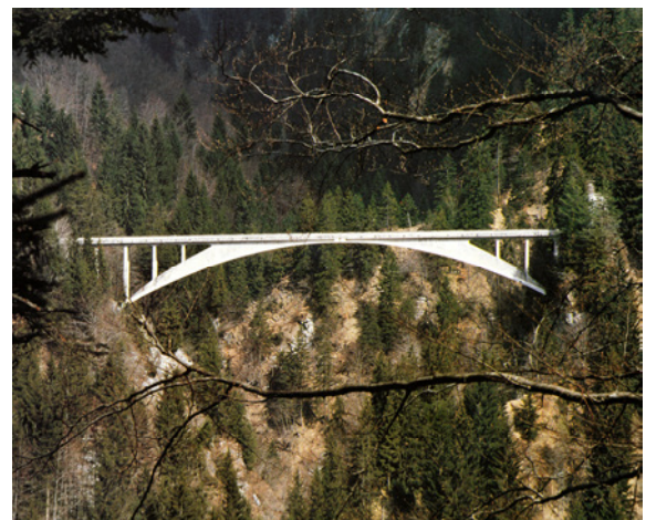
Abb. 17: Saginatobelbrücke in Graubünden (Schweiz), 1930 durch Robert Maillart, 90 m Spannweite, [9]
