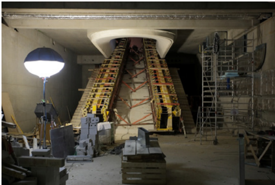
Abb. 12: Verbindungstreppe im Rohbau © Bollinger + Grohmann
