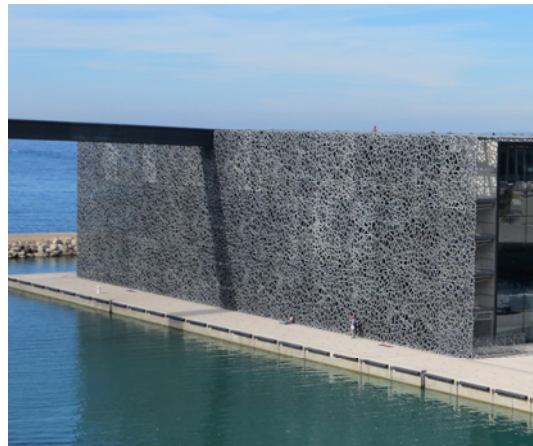
Abb.18: Fassadenelemente aus Hochleistungsbeton beim „Mucem“ in Marseille (Copyright: Fa. Lafarge, Architekt: Rudy Ricciotti, Foto: Bachmann, Ed. Züblin AG)
