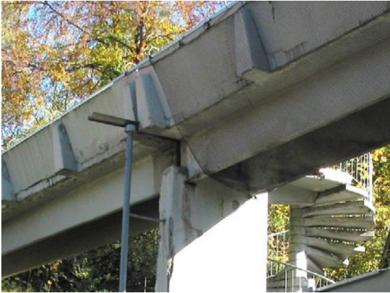
Abb. 2: Ursprüngliche Fußgängerbrücke in Albstadt mit Korrosionsschäden [Foto: Groz-Beckert]
