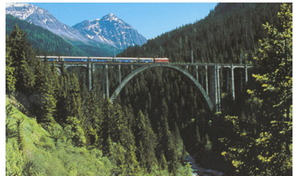
Abb. 16: Langwieser Viadukt im Zuge der Chur-Arosa-Bahn (1912-1914 durch Züblin)
