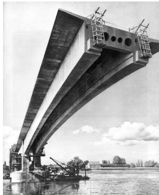
Abb. 26: Freivorbau der vorgespannten Nibelungenbrücke über den Rhein bei Worms, Spannweite 114,2 m, [12]
