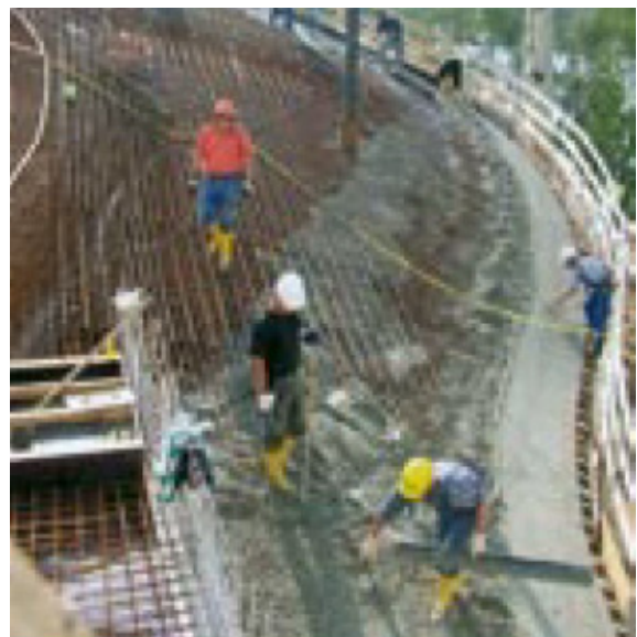
Abb. 15: Manuelles Glätten des eingebauten Betons [16]
