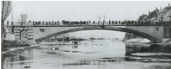
Abb. 8: Donaubrücke in Munderkingen von 1893 aus Stampfbeton, Spannweite 50 m (Bildarchiv des Deutschen Museums in München)
