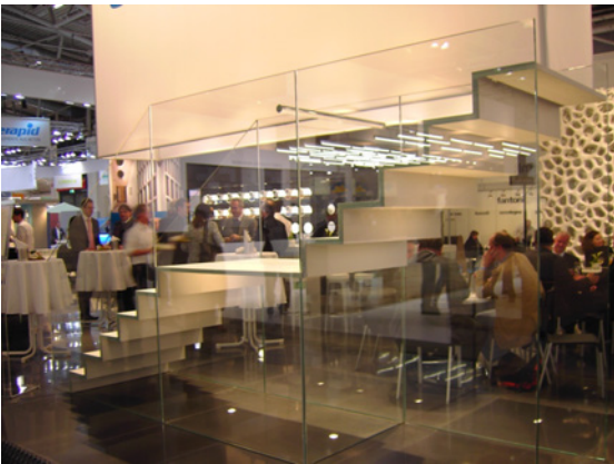
Abb. 15: Ultra-dünne Betonfertigteiltreppe aus Hochleistungsbeton mit Mikrostaalfasern (Copyright: Fa. Dyckerhoff AG, Architekt: Ourstudio, Dortmund Fertigteil: Fa. Benno Drössler GmbH, Siegen)
