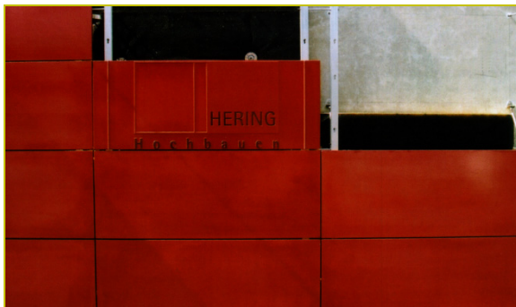
Abb. 5: Beispiel von Fassadenelementen aus textilbewehrtem Beton System „betoshell“ (Fa. Hering Bau GmbH, Burbach)
