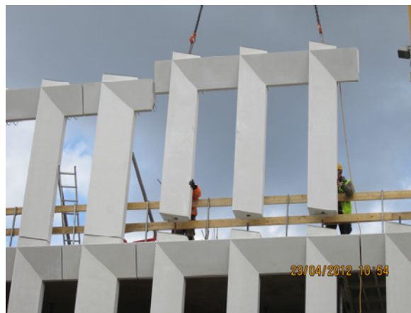
Abb. 3: Tragende Fassadenelemente beim Bauvorhaben Ohligsmühle in Wuppertal (Ausführung: Ed. Züblin AG)
