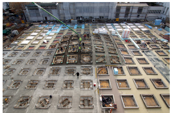
Abb. 11: Fünfter und letzter Betonierabschnitt. Fotograf: schneider+schumacher.
