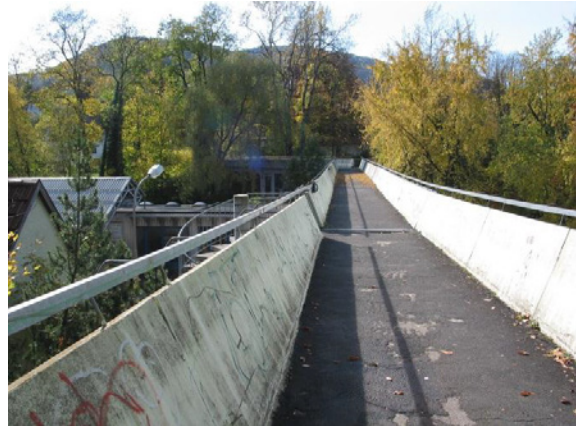
Abb. 2: Ursprüngliche Fußgängerbrücke in Albstadt mit Korrosionsschäden [Foto: Groz-Beckert]
