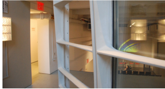
Abb. 17: Betonelemente als Fensterrahmen als Prototyp „Liquid Wall“ (Copyright: Fa. Lafarge)
