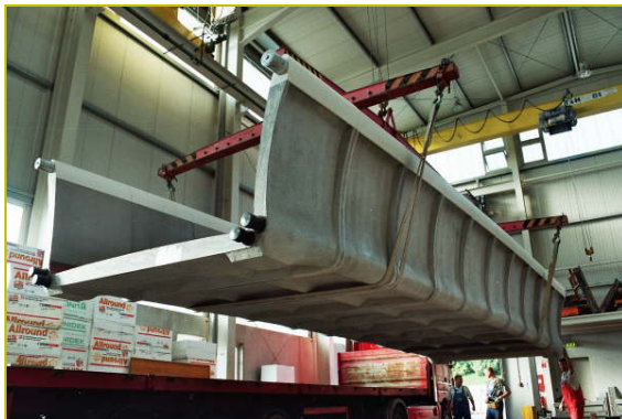
Abb. 12: Fußgängerbrücke aus Feinbeton mit Textilbewehrung und Vorspannung (Copyright: Betonwerk Oschatz, Entwicklung: Technische Universität Dresden)
