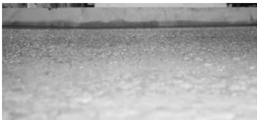
Abb. 5: Oberfläche des Brückenbauteils aus SVB 3 gemäß Tab. 1 nach dem Abziehen [11]
