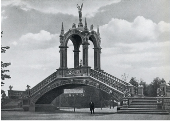
Abb. 7: Stampfbetonbogen der Firma Dyckerhoff & Widmann auf der Düsseldorfer Gewerbe- und Kunstausstellung von 1880, [3]
