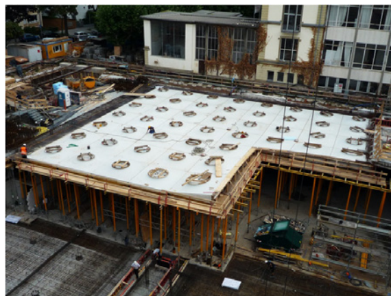
Abb. 15: Schalungselemente auf justierbaren Gerüsttürmen © Bollinger + Grohmann
