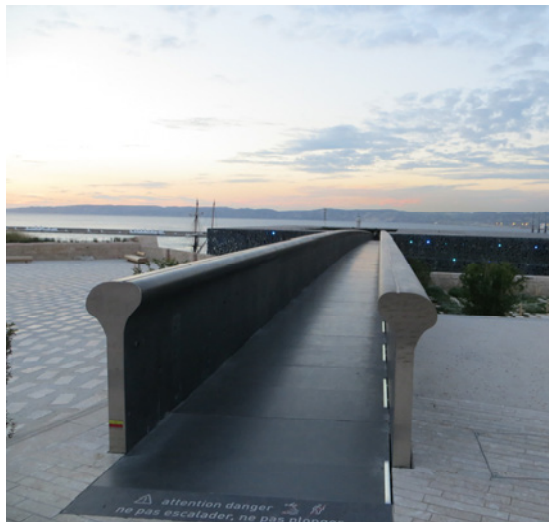
Abb. 21: Fußgängerbrücke zum „Mucem“ in Marseille- Querschnitt (Copyright: Fa. Lafarge, Architekt: Rudy Ricciotti, Foto: Bachmann, Ed. Züblin AG)
