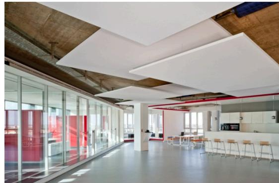
Abb. 10: Seminarbereich IGS Akustiksegel unter Betondecke
