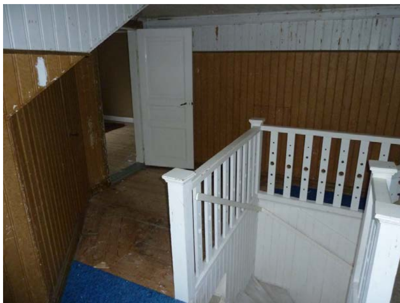
Abbildung 14: Treppenraum, Podest und Eingangstür in den Brandraum (Raum 2.) [Lyckeback und Öhrn /2012/, /63/]
