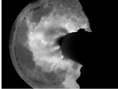
Abbildung 3.38: Beispielaufnahme eines Drehrohrofens zur Zementherstellung mit zahlreichen Anbackungen
