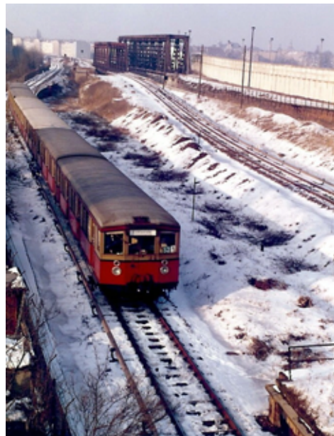
Abbildung 8 Am stillgelegten S-Bahnhof Bornholmer Straße, März 1986. Abseitigkeiten.
