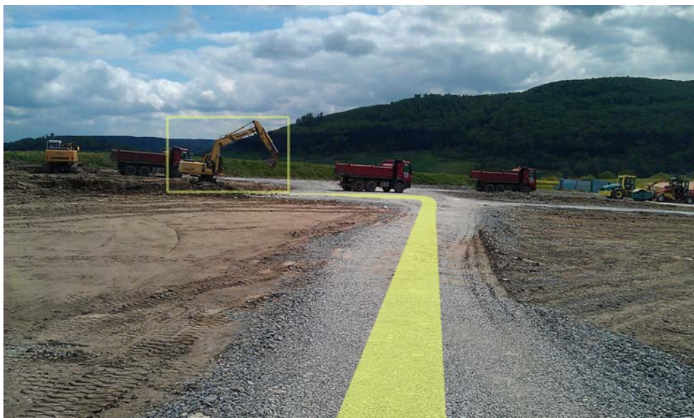
Abbildung 5.10: AR-Navigationsgerät auf der Baustelle
