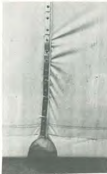
Bild 78 a - b: Singularitäten in Anschlußbereichen
