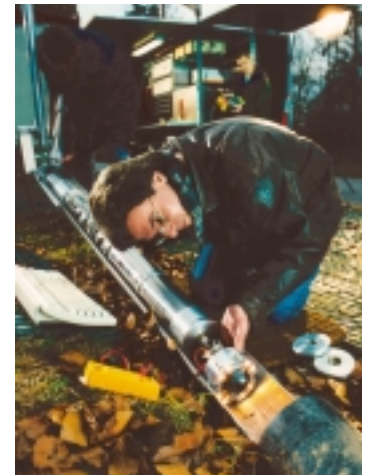
Einführung von AROBIS in den zu inspizierenden Kanal
