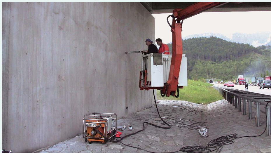
Mit einem Kernbohrgerät entnehmen Arbeiter eine Probe zur Qualitätskontrolle einer Tiefenhydrophobierung.
