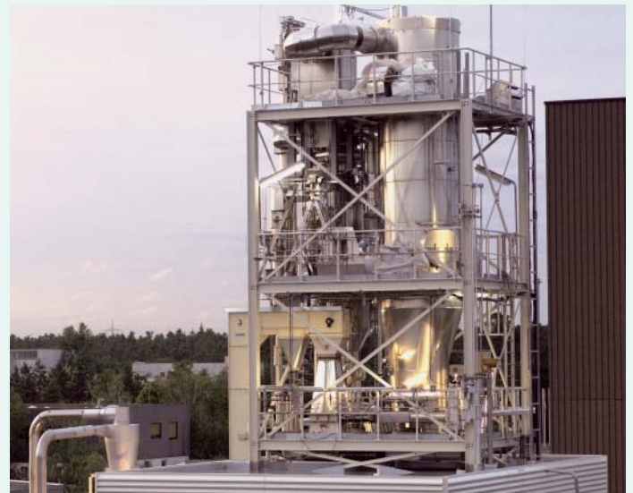
Hoch hinaus: Im oberen Teil der bioliq-Anlage zur Herstellung hochwertiger Synthesekraftstoffe findet die Schnellpyrolyse statt.
