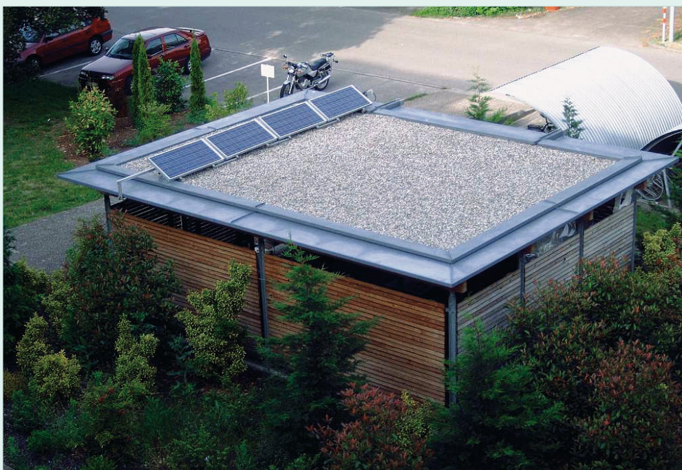
Solarzellen für die Energieversorgung der Kondensatorbankstelle.
