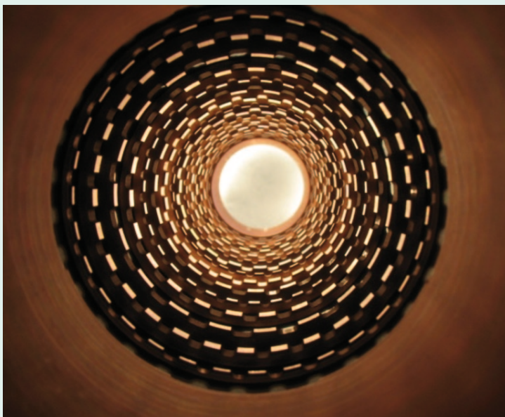
Versetzte unregelmäßige Strukturen im Strahlentunnel.
