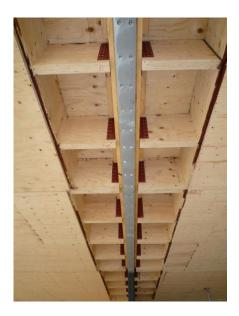
Abb. 26 Kastenelemente und Zugband
