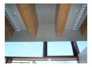
Abb. 21 Holz-Beton-Verbund (Bild: tragwerkeplus)
