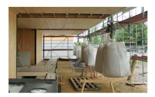
Abb. 25 Vorbelastung Kragarm (Bild: tragwerkeplus)
