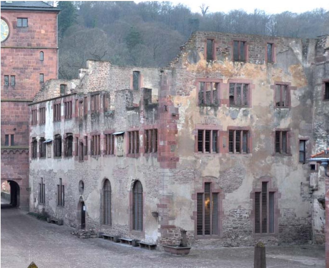
Abb. 2: Ruprechtsbau, Ansicht von Nordosten.
