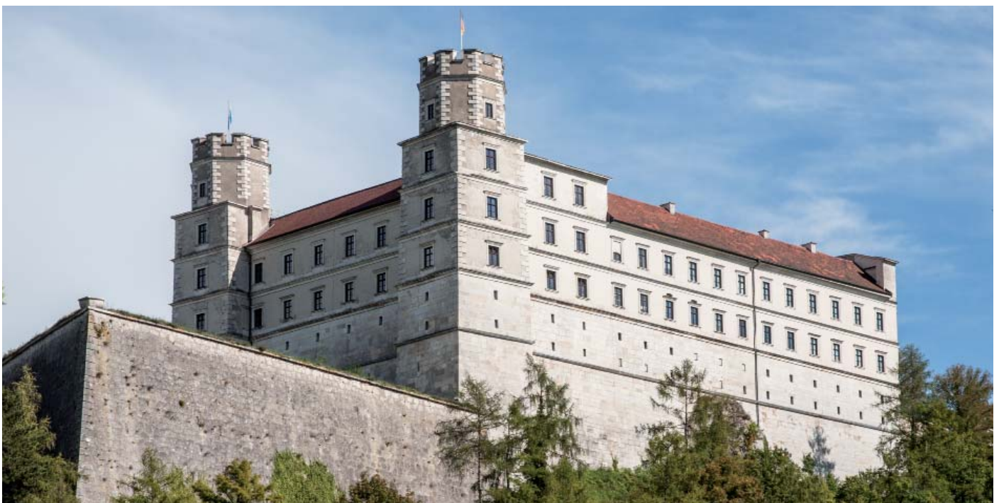
Abb. 20: Eichstätt, Willibaldsburg, Ansicht von Nordwesten. Die Westfassade der Eichstätter Willibaldsburg besitzt eine der Südfassade des Englischen Baus analoge Gestaltung (hohe Substruktionen, Geschoßgesimse, Fenster mit waagerechten Verdachungen).
