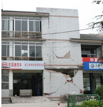
**Abb. 2-1** Schubversagen in der Ebene von Mauerwerkswänden [USGS]
