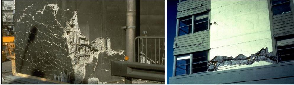
**Abb. 2-3** Biegeversagen am Beispiel von Stahlbetonwänden [NISEE a]
