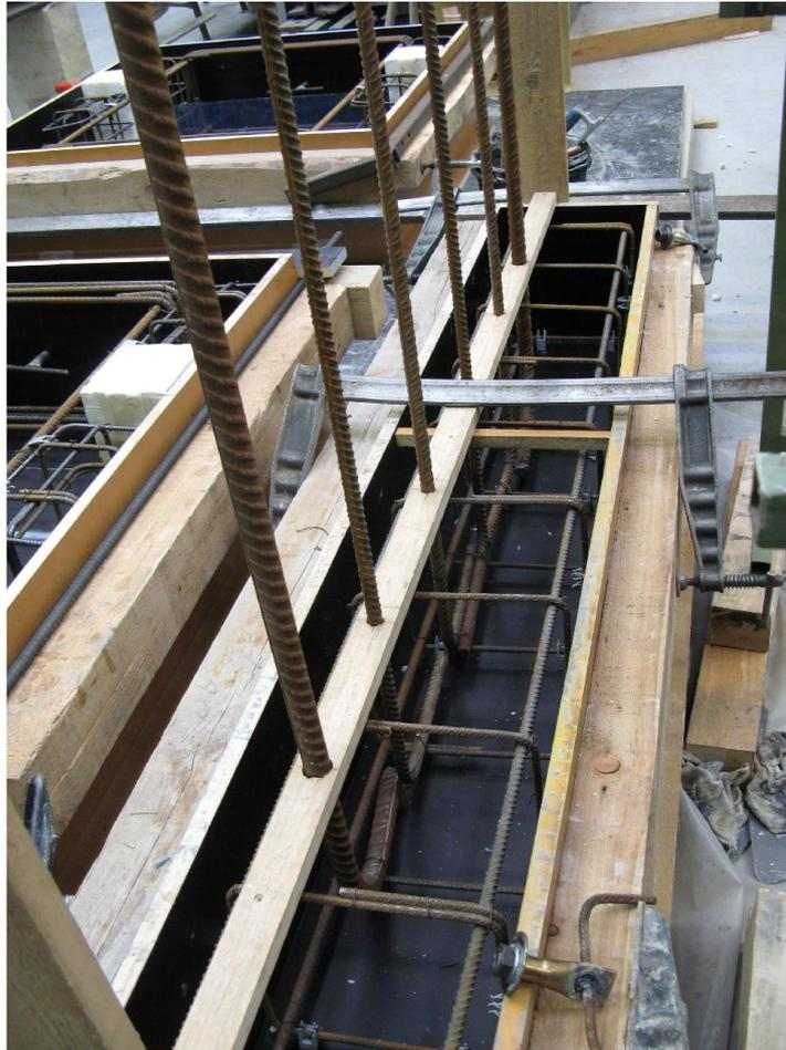
**Abb. 4-36** Schalung und Bewehrung von Stahlbetonsohlbalken und Wand
