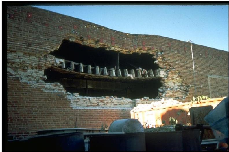
**Abb. 2-2** Biegeversagen von Mauerwerkswänden aus der Ebene heraus [NISEE c]
