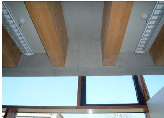
Abb. 21 Holz-Beton-Verbund (Bild: tragwerkeplus)
