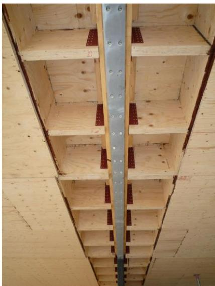
Abb. 26 Kastenelemente und Zugband
