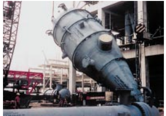
Abb. 3: Heißgasfilter für die Kohledruckvergasungsanlage in Buggenum, NL, bei der Montage 2) . Höhe 25 m, Durchmesser 4,2 m, Gewicht 90 t, Durchsatz ca. 25.000\ \text{Bm}^3/\text{h} bei 240\ ^\circ\text{C} und 22 bar entspricht 300.000\ \text{Nm}^3/\text{h} .
