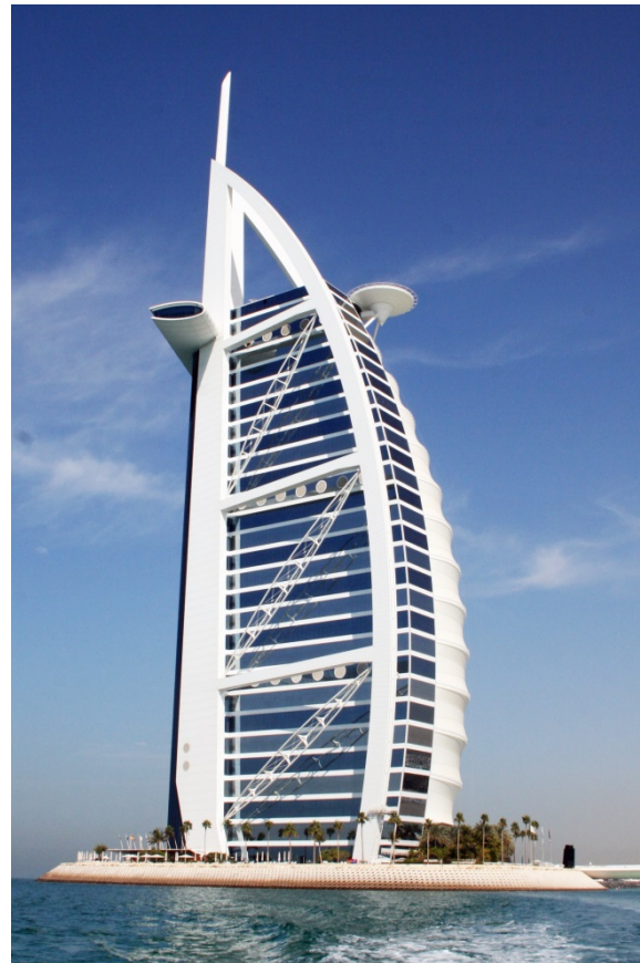
Figure 8. Dubai, Burj al Arab, 1994-99, Außenansicht
