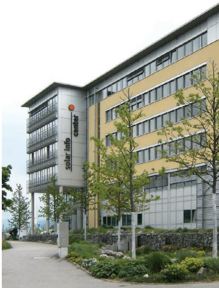
Abbildung 26 Bürogebäude „Solar Info Center“
