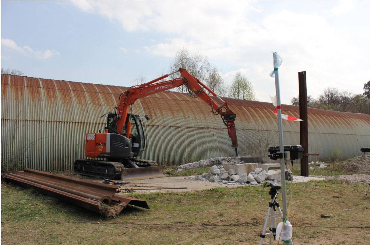
Abbildung 28: Versuchsreihe mit Hydraulikbagger und Immissionserfassungssystem (rechts)
