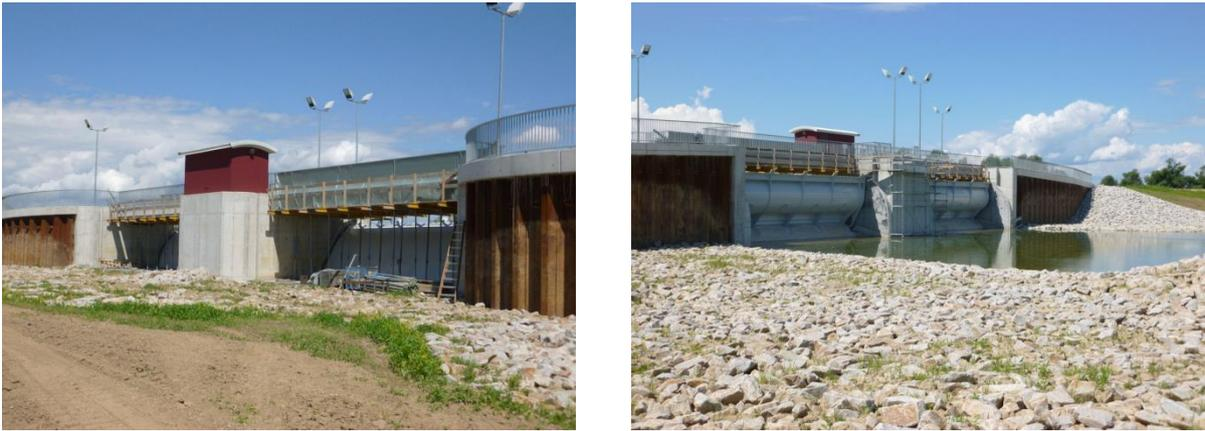
*Abbildung 8.13: Bilder von der konstruktiven Gestaltung des Einlaufbauwerks mit Fischbauchklappen des Polders Wörth / Jockgrim in Rheinlad-Pfalz, links ist die Vorlandseite und rechts ist die Polderseite mit Tosbecken (Mikovec 2012) zu sehen.*
