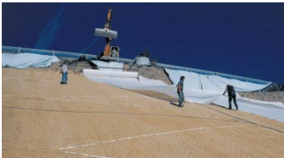
Abb. 7: Verlegung des Kabelnetzwerks auf der Mülldeponie Karlsruhe-West. Die weißen Flachbandleitungen werden kreuzförmig über die zu überwachende Fläche gelegt. Danach erfolgt eine Abdeckung mit einem Geotextil.
