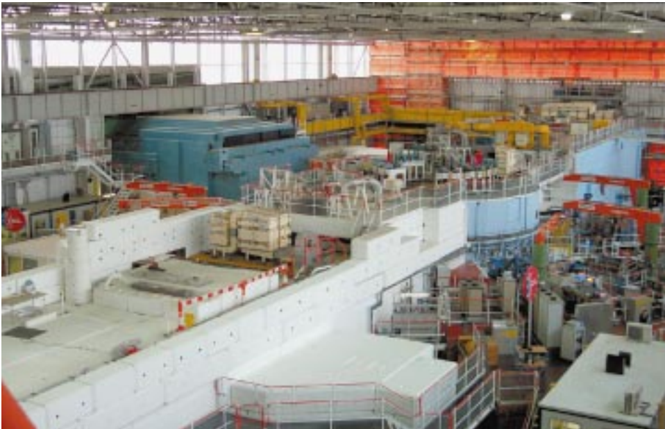
Abb. 3: Blick in die ISIS-Experimenthalle: Im Vordergrund die abgeschirmte Proton-Flugbahn, in der Mitte die Abschirmung des Targets, links im Hintergrund das KARMEN-Blockhaus aus 7000 t Stahl.
