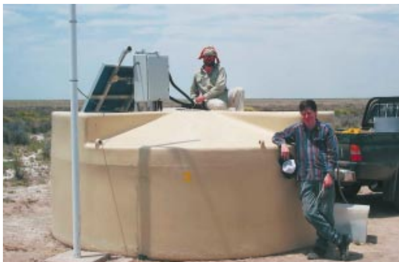
Abb. 2: Installationsarbeiten an einem Detektortank des Prototyparrays.
