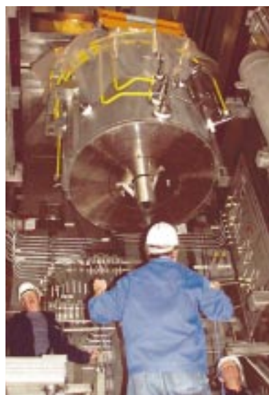
Abb. 4: Einbringung des Schmelzofens in die Schmelzofenzelle der VEK.
