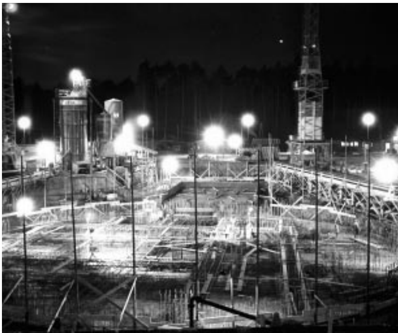
Abb. 1: Die Gründungsaufgabe der Kernreaktorbau- und Betriebsgesellschaft, der ersten Vorläuferinstitution des Forschungszentrums Karlsruhe, waren Entwicklung, Bau und Betrieb des Forschungsreaktors 2.
