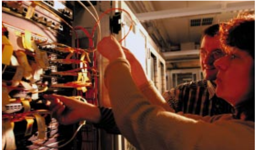
Abb. 4: Schnelle Netzwerke sind eine wichtige Voraussetzung für Grid-Computing: Mit solchen Gigabit-Ethernet-Routern sind die Computer von GridKa untereinander und mit anderen Grid-Rechenzentren in aller Welt mit Bandbreiten bis zu 20 Gigabit/s verbunden.
