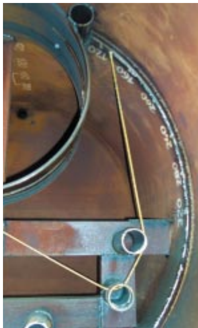
Abb. 4: Zerlegung des Reaktordrehdeckels und seiner Einbauten mit einer Seilsäge (Mock-up).
