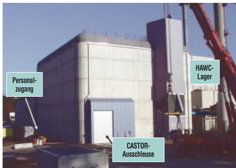
Abb. 1: Fertiggestelltes VEK-Prozessgebäude – Ansicht von Südwesten.
