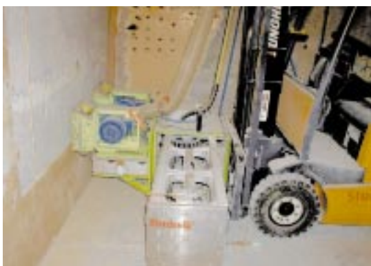
Abb. 4: Wandshaver im Einsatz.
