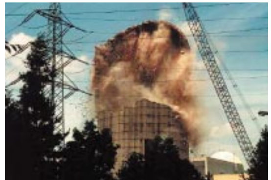
Abb. 5: Abriss des 50 m hohen Reaktorgebäudes des Heißdampfreaktors Karlstein.
