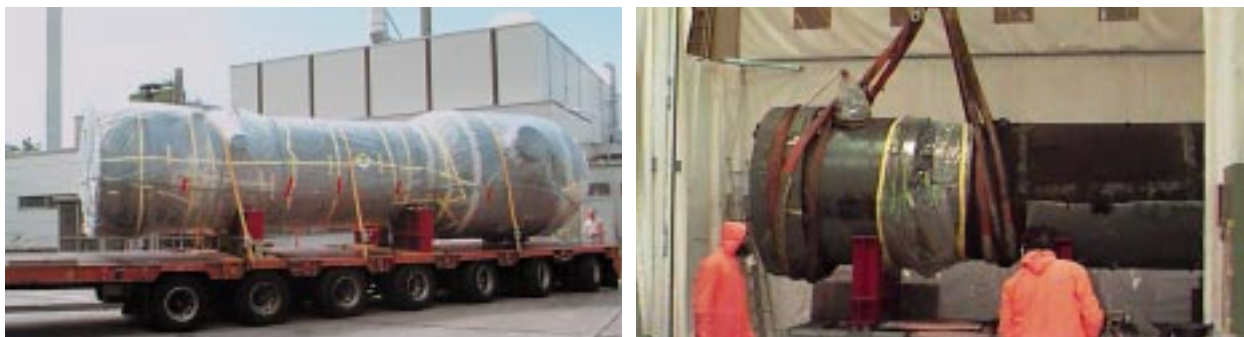
Abb.1: Antransport und Verarbeitung der Dampferzeuger des MZFR.
