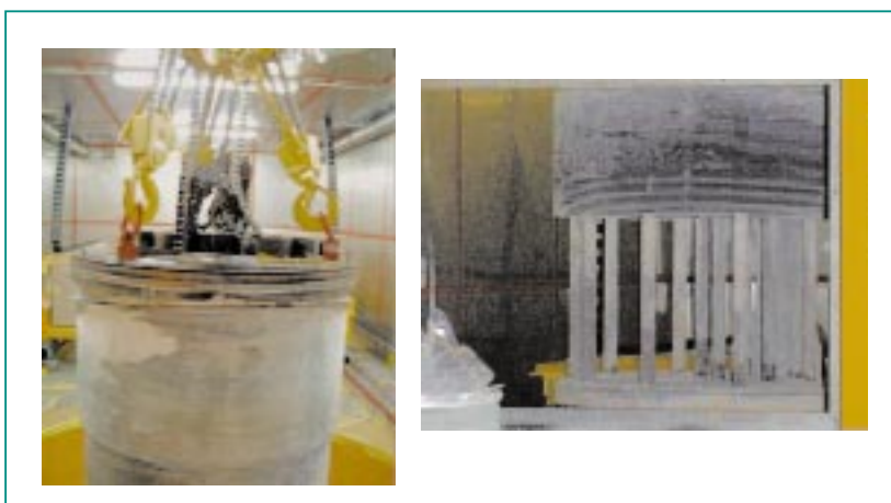
Abb. 10: Demontage des kleinen Drehdeckels.
