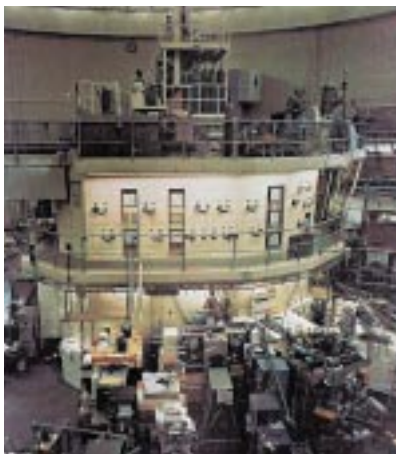
Abb. 8: Der Forschungsreaktor 2 wurde 1957–1961 errichtet und war 1961–1981 in Betrieb.
