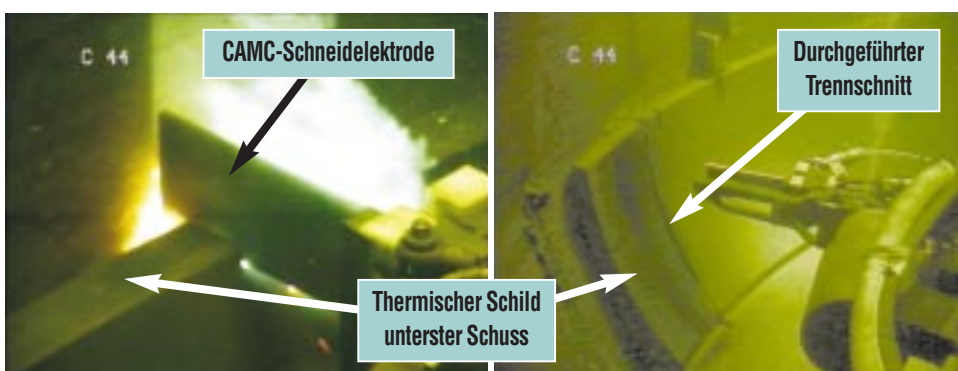
Abb. 5: Einsatz des Contact-Arc-Metal-Cutting-(CAMC)-Zerlegeverfahrens für die Zerlegung des untersten Schusses des Thermischen Schildes. Linkes Bild: Beginn der Zerlegung. Rechtes Bild: vollständiger Trennschnitt nach ca. drei Stunden Schneiddauer und anschließender achtstündiger Wasserreinigung.
