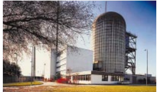
Abb. 4: Der Heißdampfreaktor Karlstein wurde von 1965 bis 1969 errichtet und war bis 1971 in Betrieb. Anschließend wurden an der Anlage umfangreiche Reaktorsicherheitsexperimente durchgeführt. Von 1992 bis 1998 wurde der Reaktor zur „grünen Wiese“ zurückgebaut.
