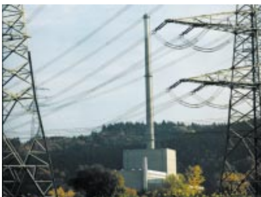
Abb. 2: Das Kernkraftwerk Niederaichbach wurde von 1966 bis 1972 errichtet und war von 1972 bis 1974 in Betrieb. 1995 war der Rückbau zur „grünen Wiese“ abgeschlossen.
