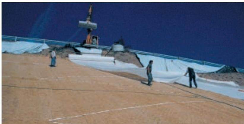
Abb. 2: Einbau von TAUPE-Feuchtesensoren auf der Mülldeponie KA-West.
