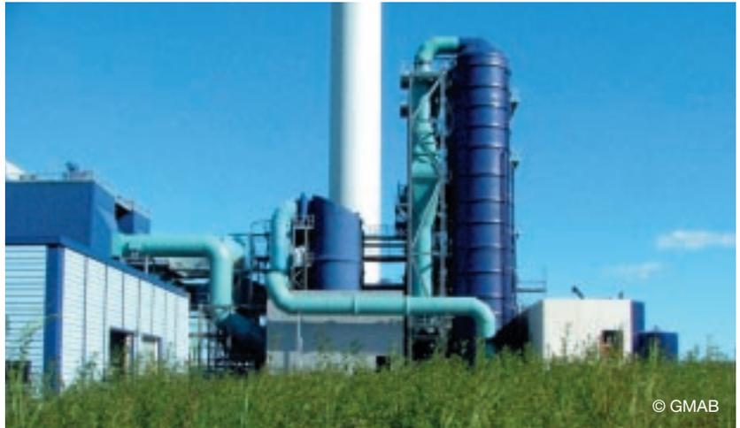
**Abb. 4: Bild der Nasswäscher der MVA Holstebro.**
