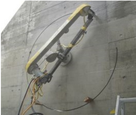
Abbildung 20: Eine Kreisseilsäge im Einsatz [61]
