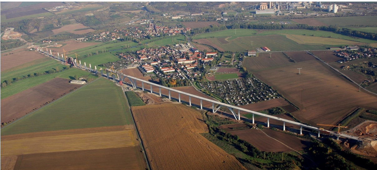
Abb. 12 Zweigleisige Bundesbahnbrücke über die Unstrut mit einer Gesamtlänge von 2669 m
