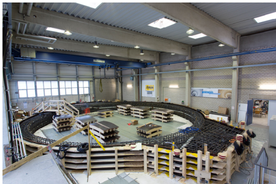
Abb. 6 Übersicht über den Versuchskörper vor Betonage
