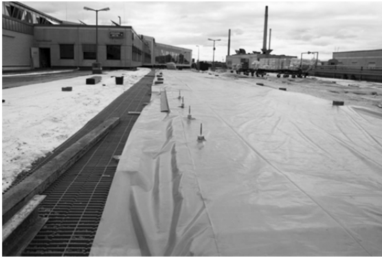
Abb. 23: Abdeckung der fertiggestellten Betonoberfläche mit PE-Folien und Einstecken der Minisensoren
