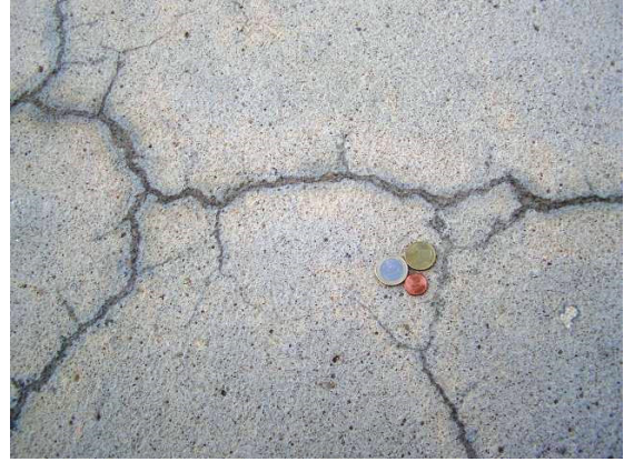
Abb. 1: Plastisches Schwinden: typisches Rissbild von netzartigen, ungerichteten Rissen auf einer Betonoberfläche in direkter Sonneneinstrahlung und Windbelastung
