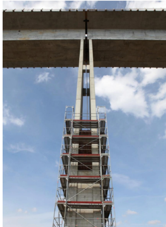
Abb. 17 Ausbildung des Doppelpfeilers im Bauzustand (Quelle Wikimedia)
