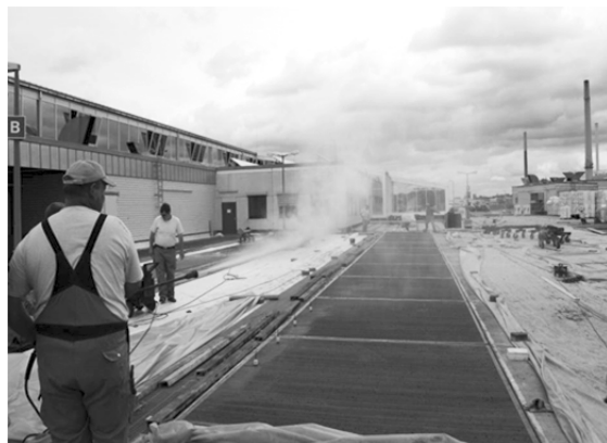
Abb. 17: Befeuchtung einer Betonoberfläche mit einer Nebellanze
