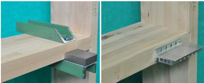
*Bild 3-35 Starre Einspannung des Riegels (links) und Glasauflager (rechts)*
