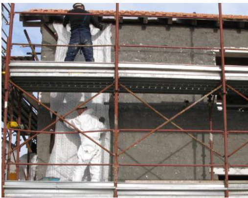
Abb. 4.56: Einbettung der durchgehenden Gewebbahnen (links), Geschädigtes Gebäude (G2), (gestrichelt Risse in Fasern und schraffiert Delamination) (rechts)
