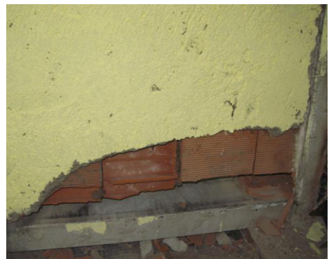
Abb. 4.114: Unverstärkte Wand: Riss an Türecke beginnend, (links); Versagen der unteren Steinreihe auf Schub (rechts)
