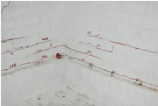
Abb. 4.77: Rissbild an der Nord-Ost-Ecke des Gebäude (G4) (links), Spaltrisse im Sockel an der Nord-Ost-Ecke (rechts)
