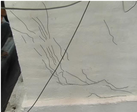
Abb. 4.79: Feine Einzelrisse auf der Außenseite der Süd-West-Ecke (links), vertikal endender Einzelriss auf der Innenseite der Süd-West-Ecke (rechts)
