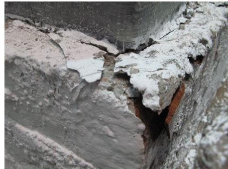
Abb. 4.77: Rissbild an der Nord-Ost-Ecke des Gebäude (G4) (links), Spaltrisse im Sockel an der Nord-Ost-Ecke (rechts)
