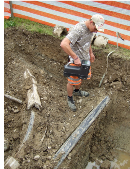
(b) Das Ortungssystem Digital Control im Einsatz
