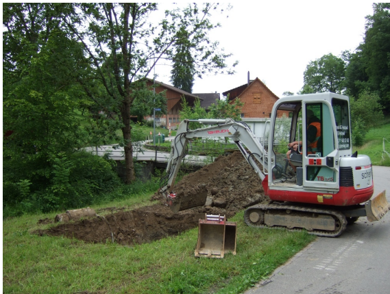
(a) Aushebung am Anfang der Bohrung
