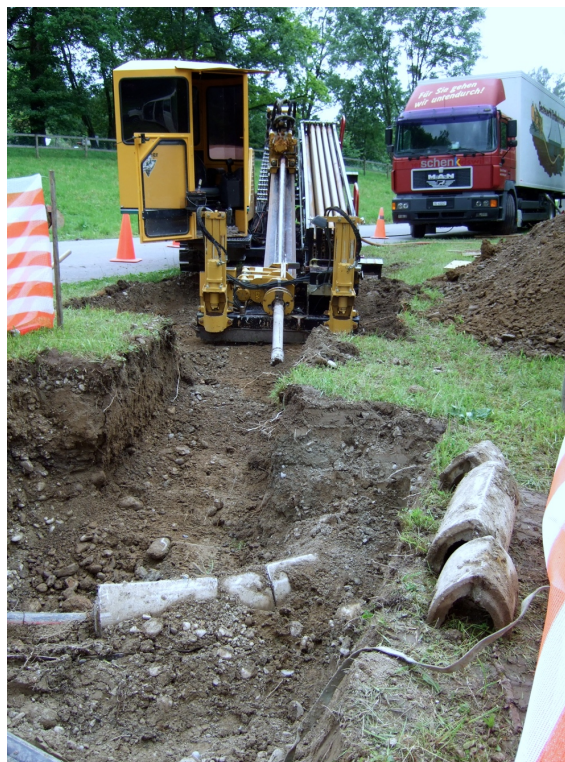
(c) Bohrmaschine mit LKW für die Bohrspülung
