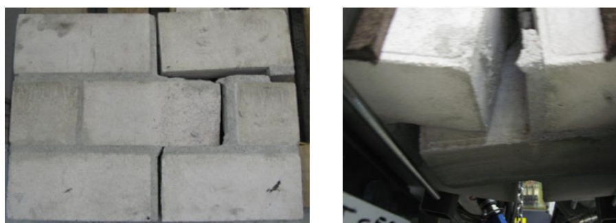
Abb. 4.83: Stufenförmiger Riss der Probe (O1) (links); Torsion und Verschiebung in den Fugen am Mittelstein, Probe (O1) (rechts)
