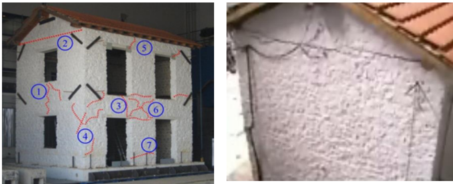
Abb. 4.51: Sieben Positionen von Rissen am geschädigten Gebäude (G1) (links), Horizontaler Out-of-plane- Riss während der Belastungsstufe 3 (rechts)
