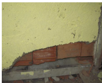
Abb. 4.114: Unverstärkte Wand: Riss an Türecke beginnend, (links); Versagen der unteren Steinreihe auf Schub (rechts)
