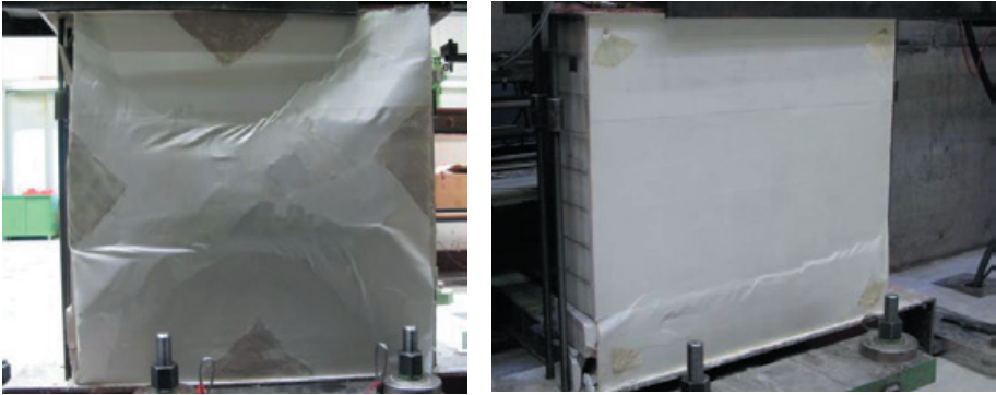
Abb. 4.34: Versagensbild Wand (W11) (links); Versagensbild Wand (W12) (rechts)
