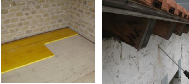
Abb. 4.55: Versteifung der Holzdecke mit Schaltafeln (links), Verbindung Mauerwerk zu Dach mit Stahldübelankern (rechts)
