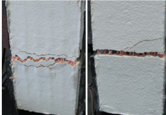
Abb. 4.4: (links) Verbundversagen durch lokales Versagen der Deckschicht an den Zugfasern (Versagen: Mörtelschicht 2), (rechts) dickere Deckschicht führt nicht zu vertikalen Rissen (Versagen: Faser-Mörtel)
