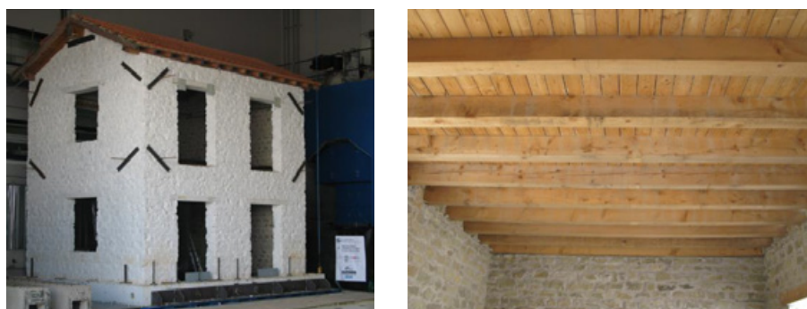
Abb. 4.42: Natursteingebäude unverstärkt (links), Holzbalkendecke im EG (rechts)
