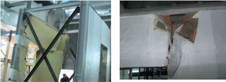
Abb. 4.115: Kollaps der unverstärkten Wand (links); Versagen der Fasern und Steine auf Zug (rechts)
