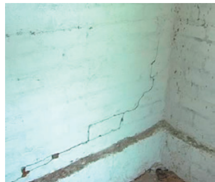
Abb. 4.79: Feine Einzelrisse auf der Außenseite der Süd-West-Ecke (links), vertikal endender Einzelriss auf der Innenseite der Süd-West-Ecke (rechts)
