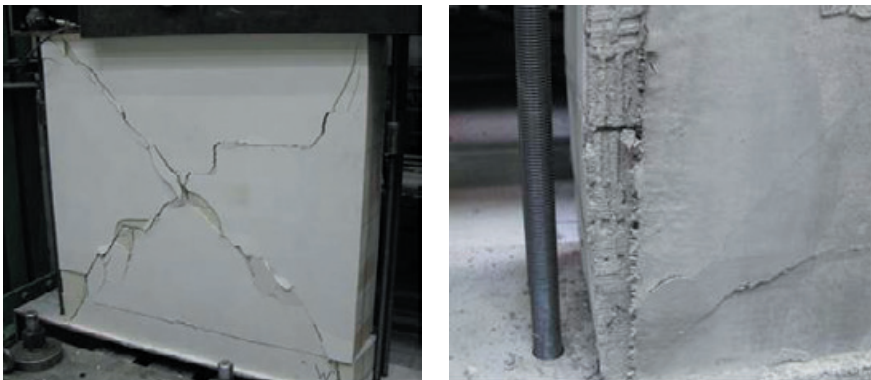
Abb. 4.28: Schubversagen bei Wand (W5) (links); Delamination bei Wand (W6) (rechts)
