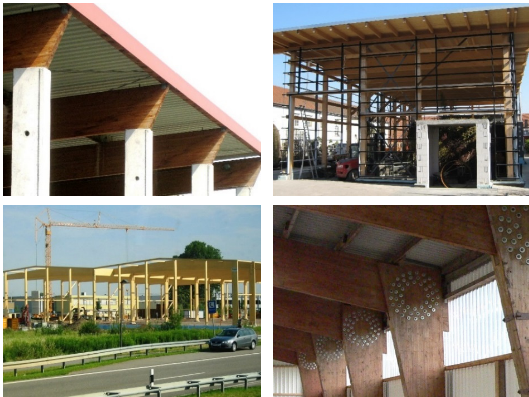
Bild 13: Umstände, die zu Schäden führen können: Während der Planung/Ausführung nicht realisierte Gabellagerung ( oben links ), der Bauphysik zuzuzählende mögliche Rissbildung in BS-Holz durch lokale Aufheizung/Austrocknung hinter geplanten Verglasungen ( oben rechts ), durch die Montage bedingte Bewitterung von BS-Holz ( unten links ) und Konstruktion von Dübelkreisen, in denen beim Schwinden Zwangsspannungen wirken ( unten rechts )
