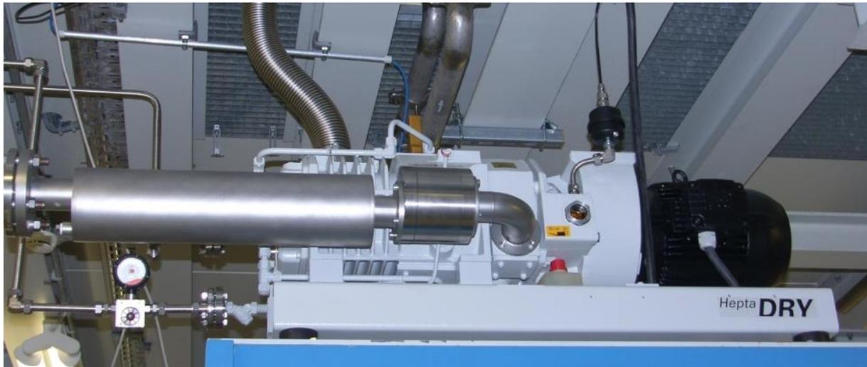
Abb. 9-6: Trocken laufende Schraubenpumpe vom Typ Hepta 200
