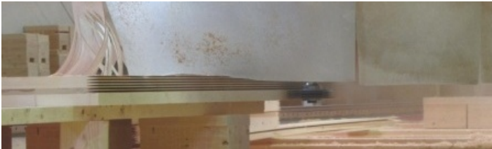
Bild 3-1: Fräsen der Universal-Keilzinkenverbindung bei einer dreilagigen Brettsperrholzplatte
