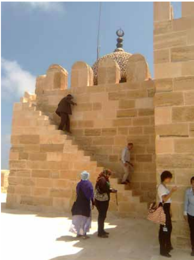
Abb. 388. Zentraler Dachaufbau: Blick nach Osten.
