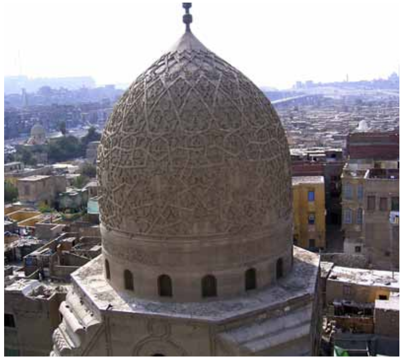
Abb. 540. SCA 99 - Mausoleum des Qaitbay, Kuppel (1470).
