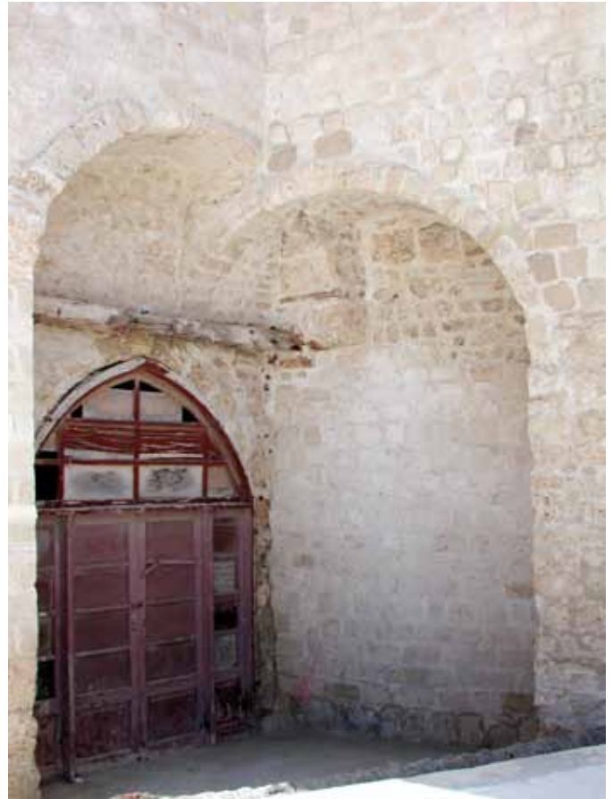
Abb. 82. Rückwärtiges Portal des Torbaus: Ausgang zum Innenhof.
