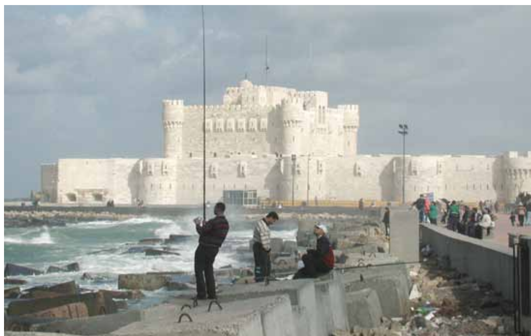
Abb. 108. Ansicht von Westen.
