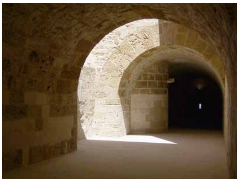
Abb. 255. Hauptturm: Tunnel an der Ostfassade, Blick nach Norden.
