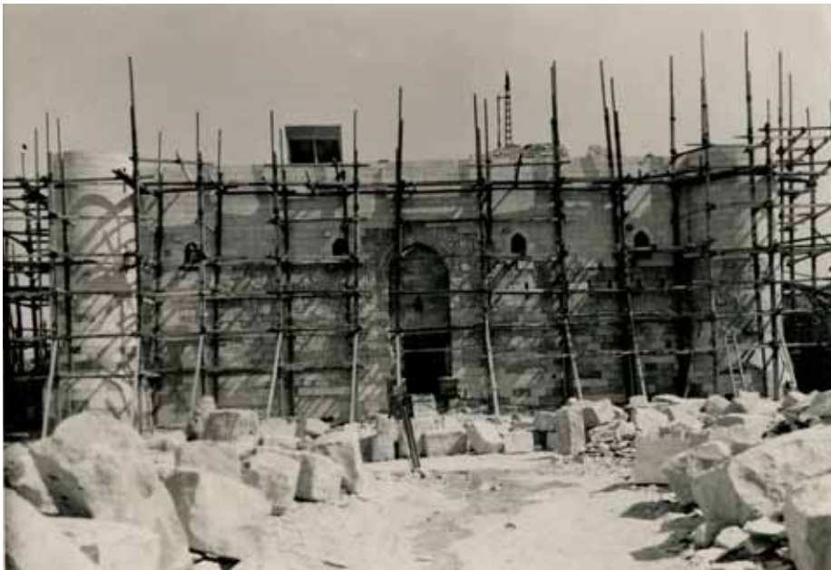
Abb. 265. Hauptturm: Südfassade während des Wiederaufbaus, 1939 (SCA).
