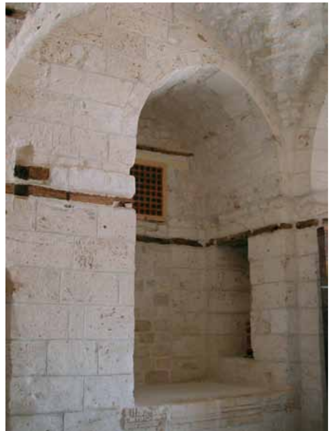
Abb. 331. Vestibül: östliche Steinbank.
