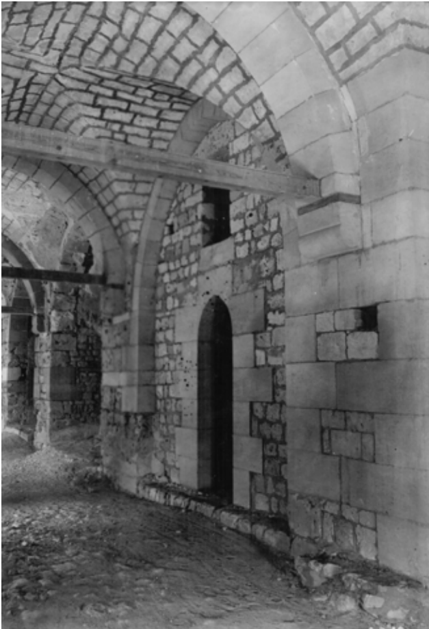
Abb. 375. 1. Obergeschoss: westlicher Umgang, Blick nach Norden, 1949 (SCA).
