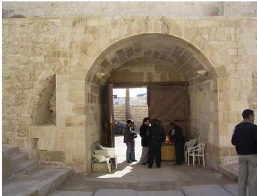
Abb. 152. Südliche Vormauer: Eingangstor, Innenansicht.
