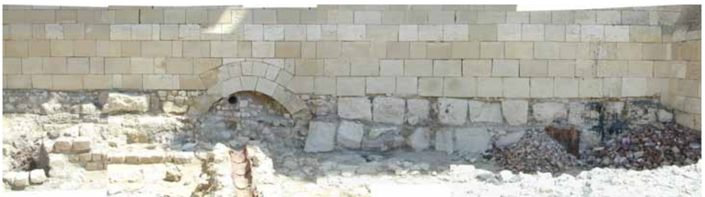
Abb. 240. Hauptturm: Westfassade, Sockelzone mit unregelmäßigen Fundamentquadern, 2001.
