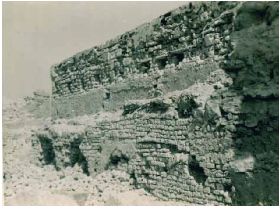
Abb. 166. Östliche Vormauer, Innenansicht 1904 (SCA).
