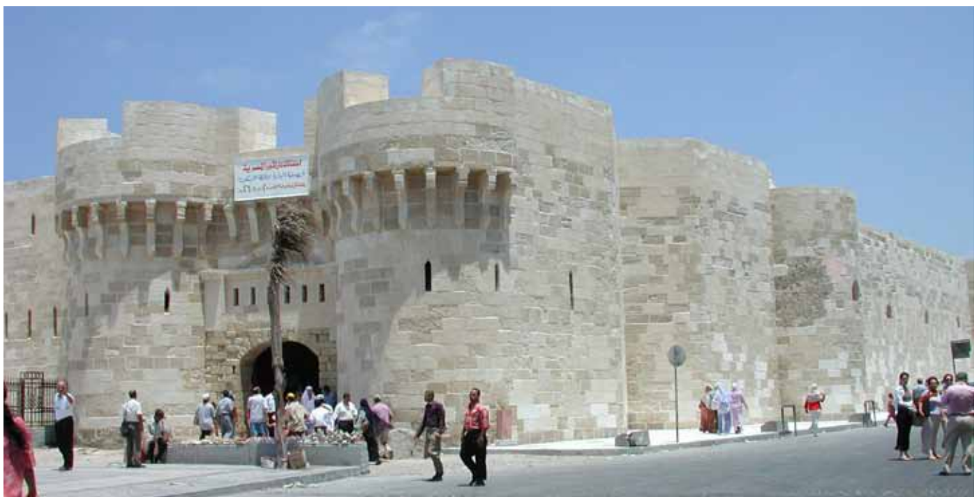
Abb. 122. Der Torbau mit der daran anschließenden Südmauer.
