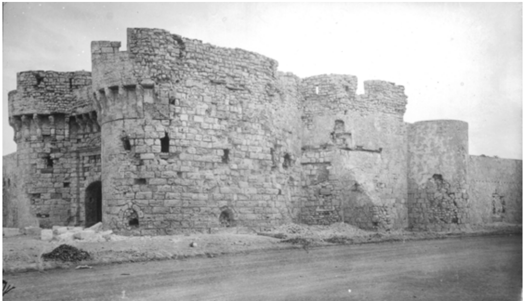
Abb. 124. Der Torbau, Südansicht, 1904 (SCA).
