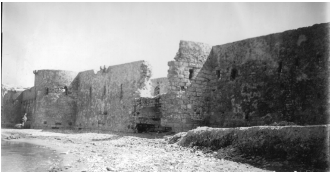
Abb. 119. Ansicht der zerstörten Westmauer, 1904 (SCA).
