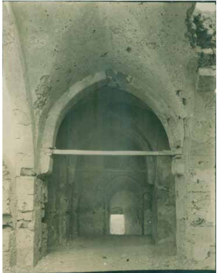
Abb. 376. 1. Obergeschoss: östlicher Umgang, Blick nach Norden, 1904 (SCA).
