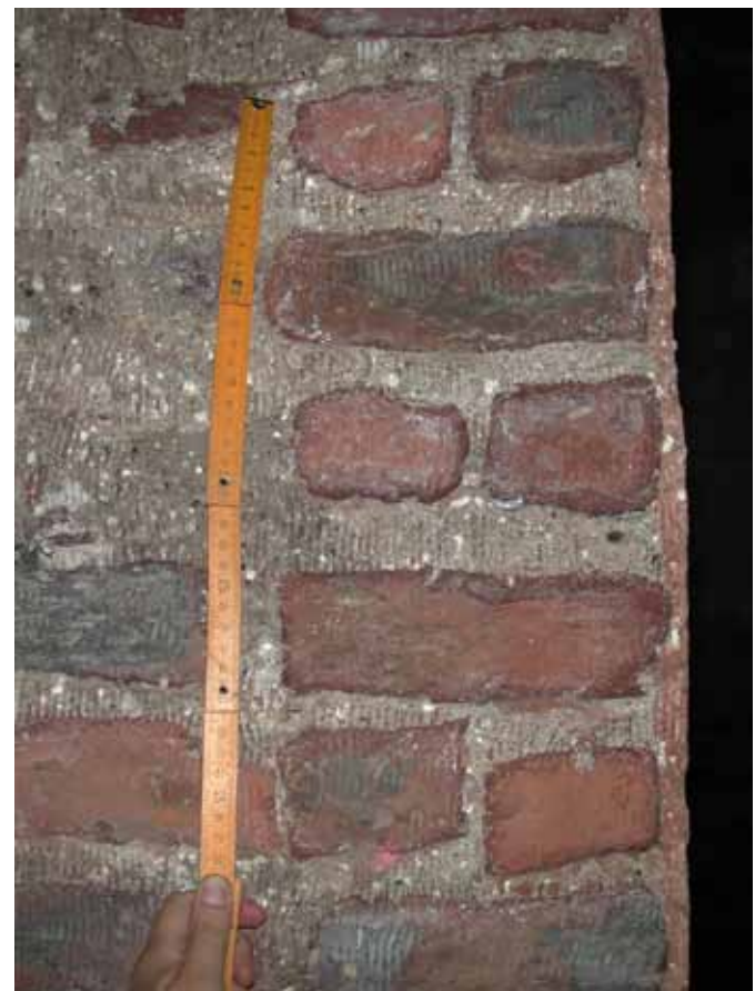
Abb. 212. Zisterne 1: durchschnittenes Wandmauerwerk, 2002.
