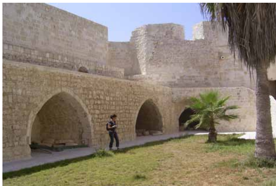
Abb. 151. Südlicher Zwinger: Blick nach Südwesten.
