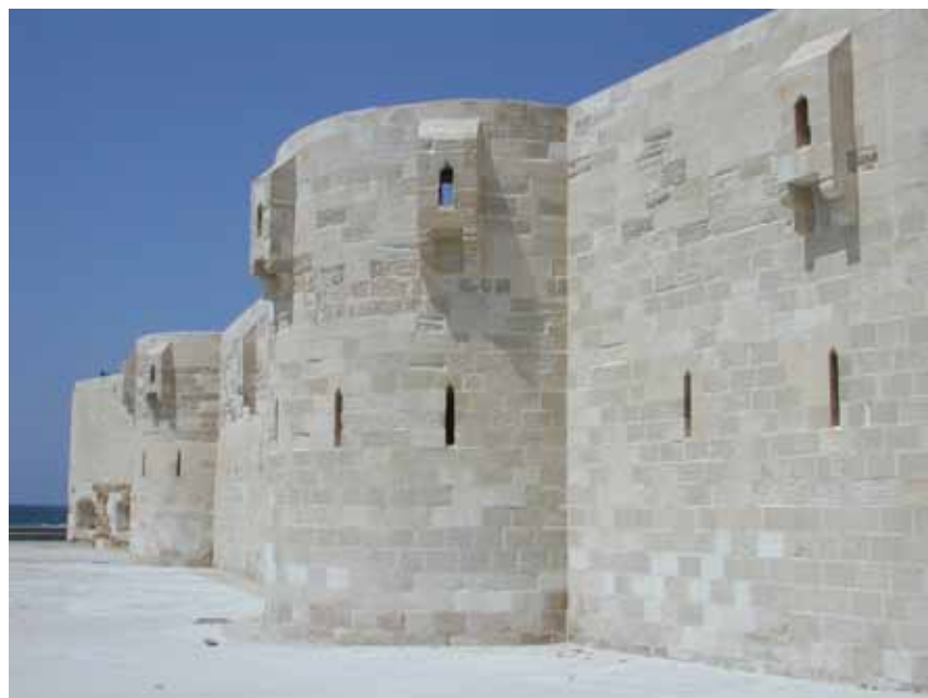
Abb. 116. Die westliche Vormauer mit den Flankierungstürmen.
