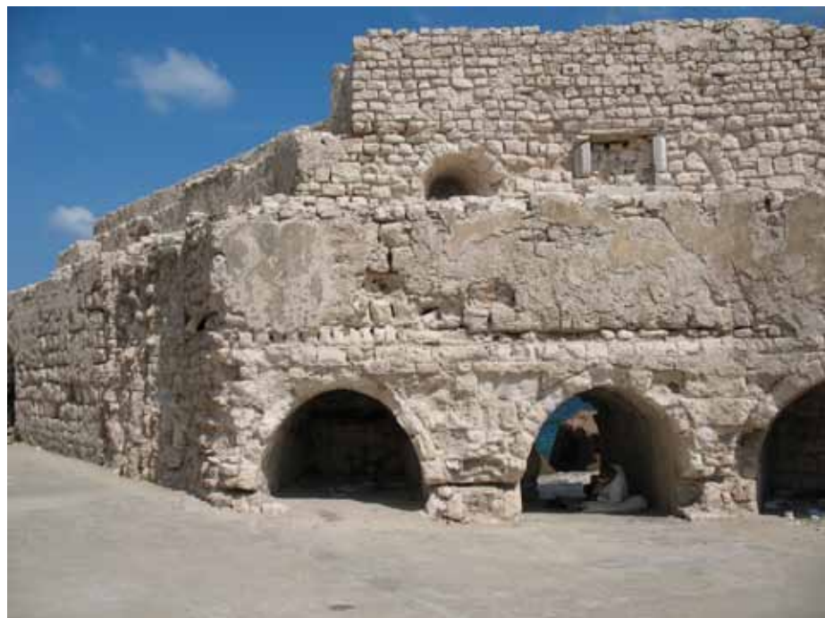
Abb. 164. Geschütznischen in der östlichen Vormauer.
