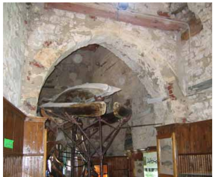
Abb. 80. Der Torbau: inneres Spitzbogenportal.
