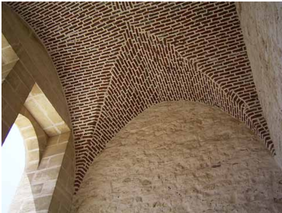
Abb. 382. 2. Obergeschoss: Gewölbe der Loggia.
