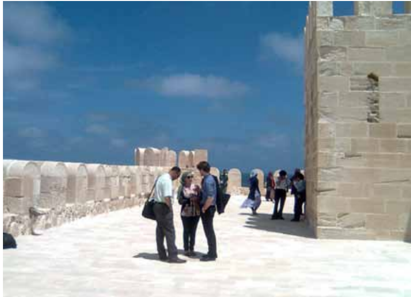
Abb. 385. Dachfläche: Blick nach Norden.
