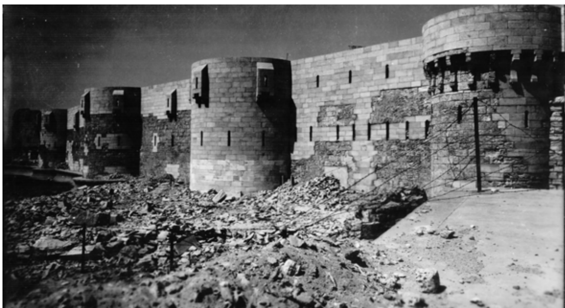
Abb. 120. Ansicht der wiederaufgebauten Westmauer, 1949 (SCA).
