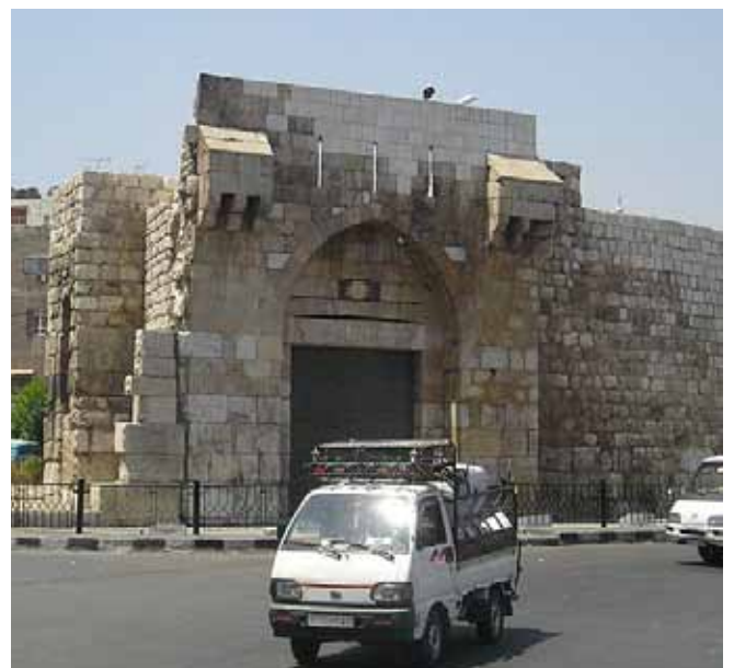
Abb. 423. Bâb Tôma (1227), Damaskus, Stadtmauer.
