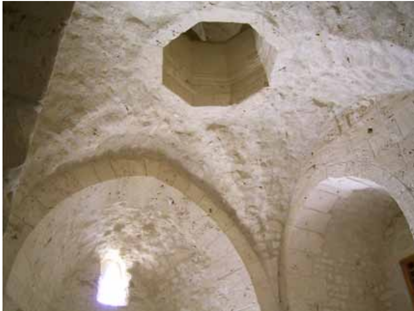
Abb. 334. Vestibül: Faltgewölbe mit der Kommunikationsluke.
