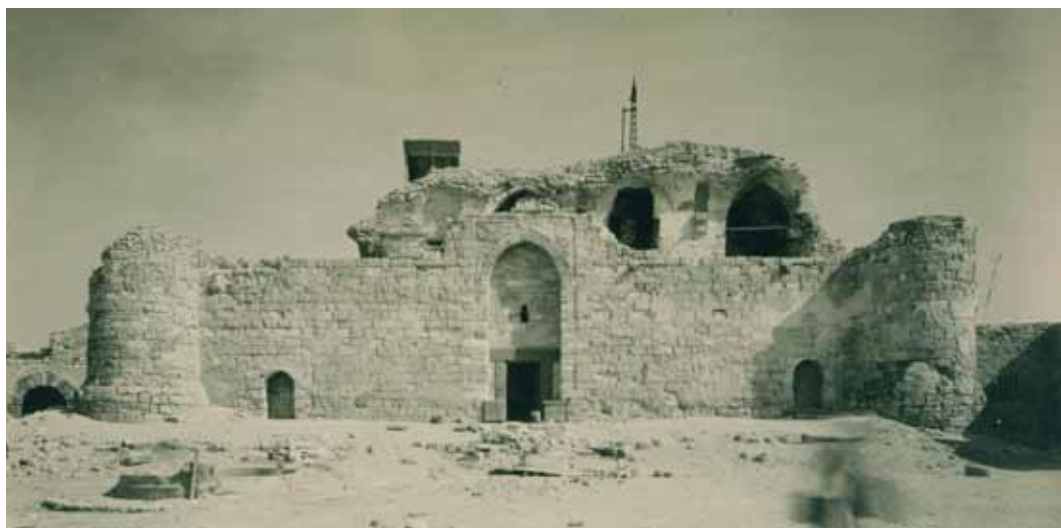
Abb. 266. Hauptturm: Südfassade nach der Teilniederlegung, 1904 (SCA).
