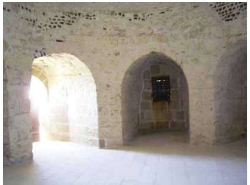
Abb. 175. Nördlicher Geschützturm, Innenraum.
