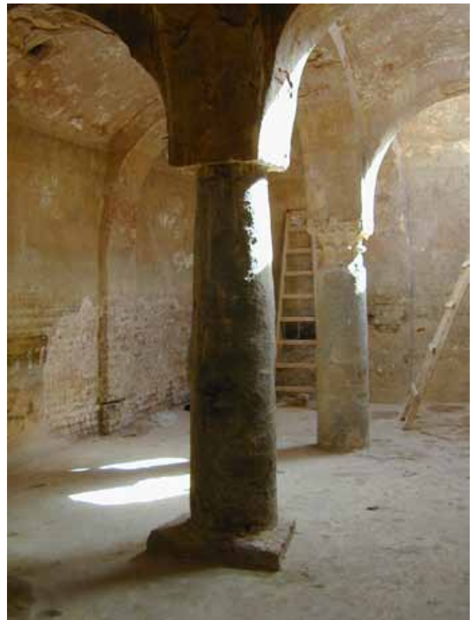
Abb. 207. Zisterne 1: Innenansicht, Blick nach Südosten, 2001.
