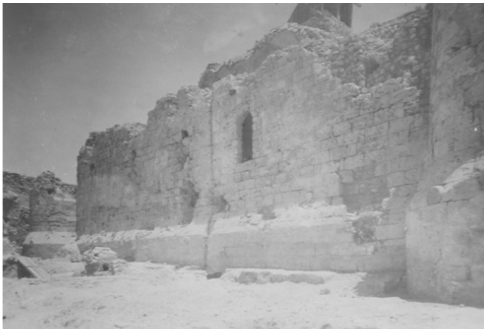
Abb. 245. Hauptturm: Westfassade, 1904 (SCA).
