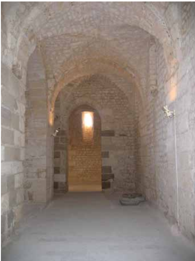
Abb. 350. Westsaal: Blick nach Süden.
