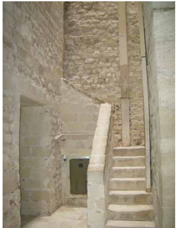
Abb. 345. Manwar zwischen Ostsaal und Treppenhhaus.
