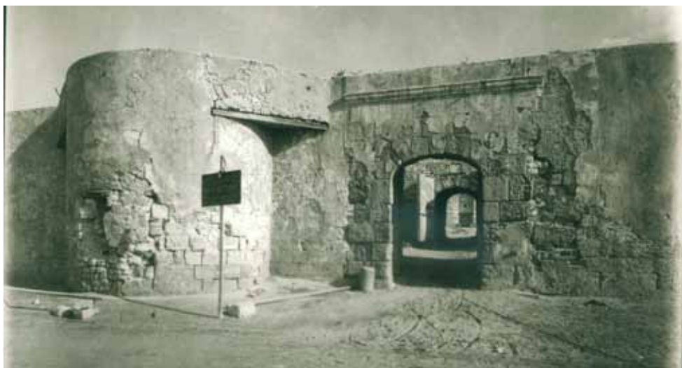
Abb. 131. Früheres Eingangsportal mit Segmentbogen-Abschluss, 1904 (SCA).
