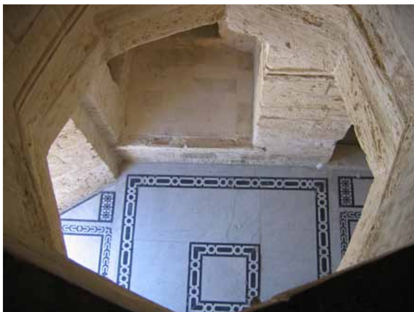
Abb. 336. Vestibül: Blick von oben.
