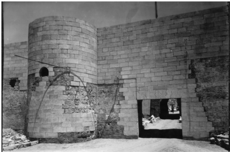
Abb. 130. Restauriertes Eingangsportal mit geradem Sturz und erhöhter Mauer, 1949 (SCA).
