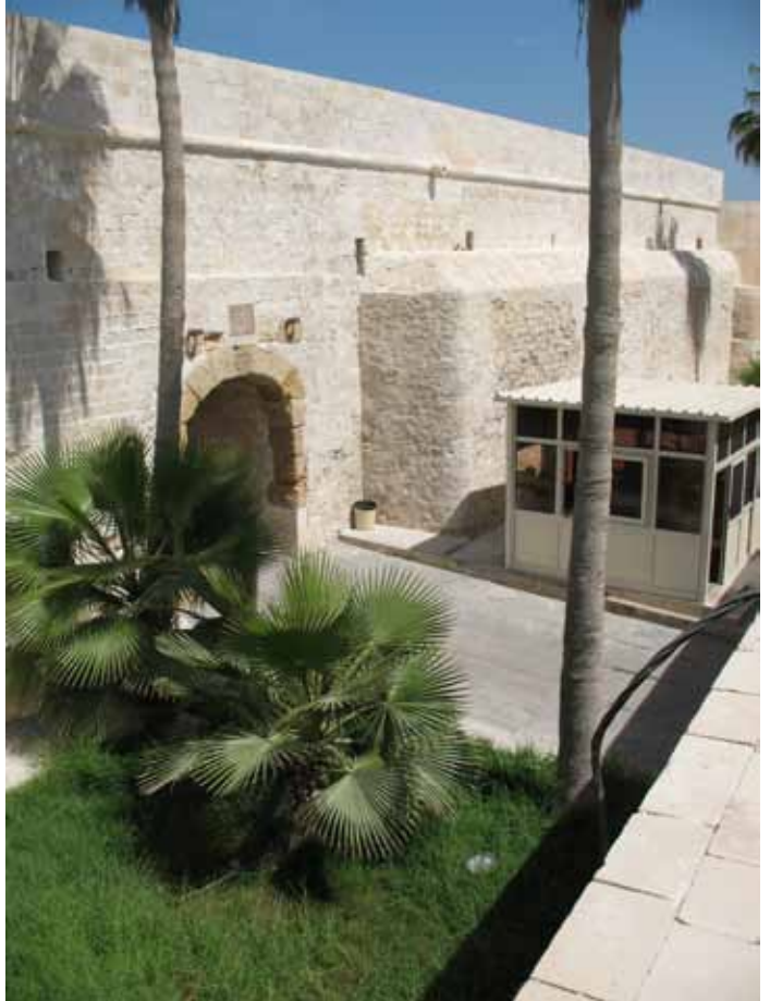
Abb. 159. Südliche Hauptmauer. Eingangspassage und östlicher Mauerabschnitt.
