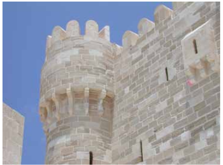
Abb. 242. Hauptturm: Westfassade, Details.
