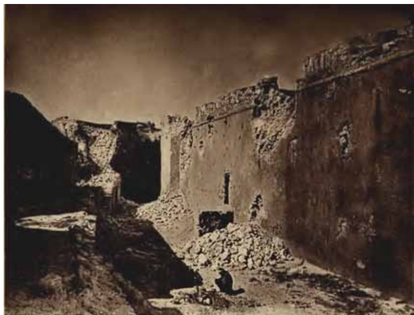
Abb. 148. Westlicher Zwinger: zerstörte Innenmauer (GOODRICH 1883, Taf. 11).
