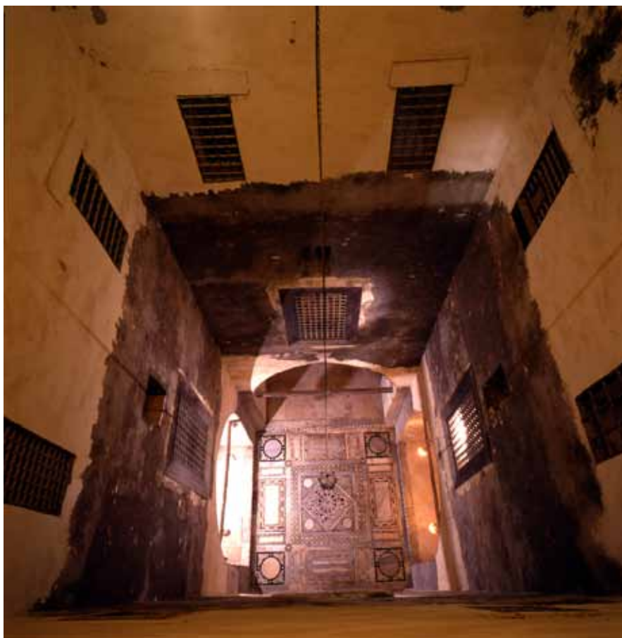
Abb. 360. Moschee: Blick vom Dach auf den Sahn , 1975 (CEAlex).
