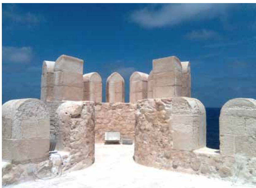
Abb. 387. Dachfläche: begehbare Eckturm.
