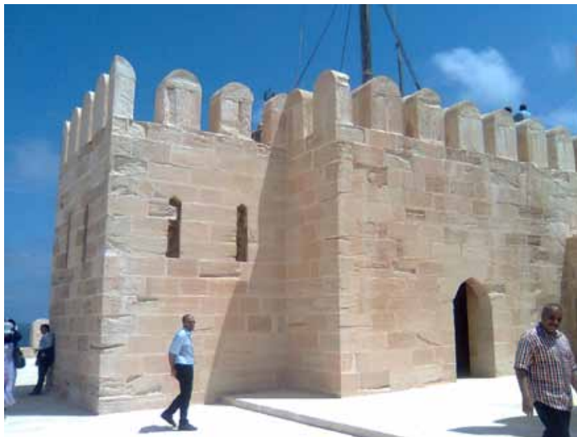
Abb. 386. Zentraler Dachaufbau: Blick nach Norden.
