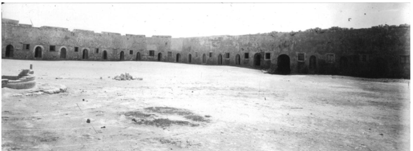
Abb. 190. Innenhof: Blick nach Südosten, 1904 (SCA).
