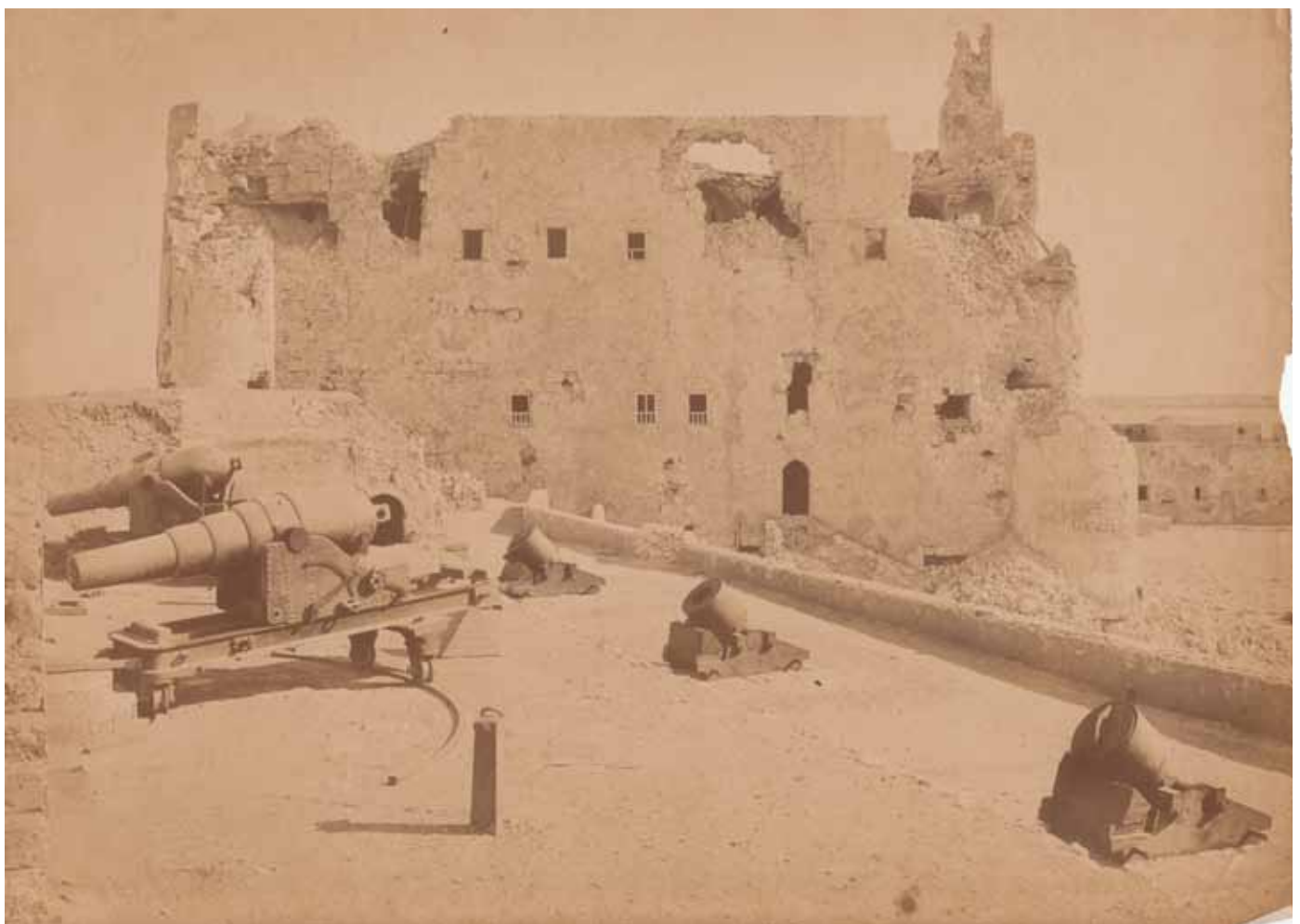
Abb. 243. Hauptturm: Westfassade, 1882 (L. Fiorillo).
