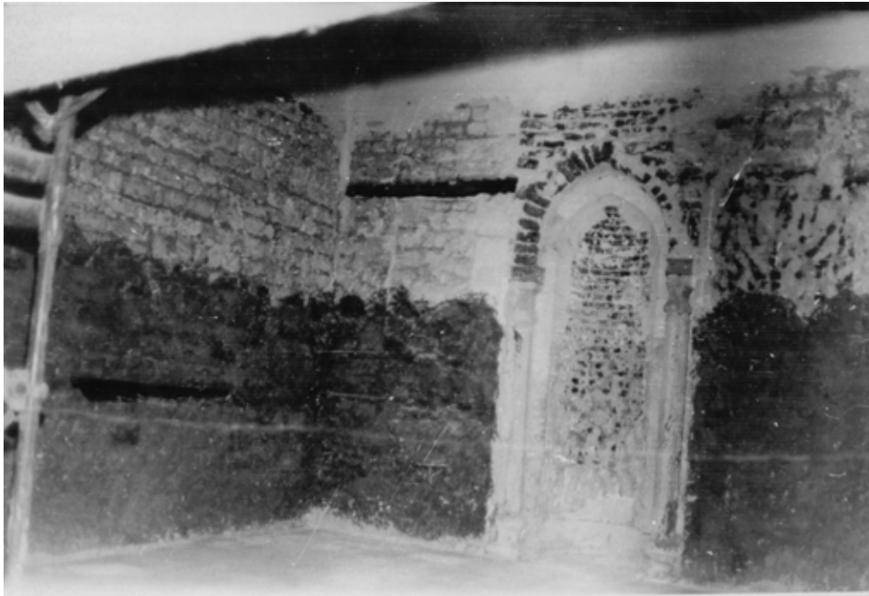
Abb. 365. Qibla-lwân während der Restaurierung von 1964 (SCA).
