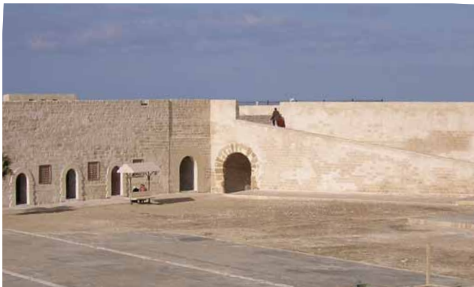
Abb. 183. Innenhof: Rampe an der nördlichen Geschützplattform.
