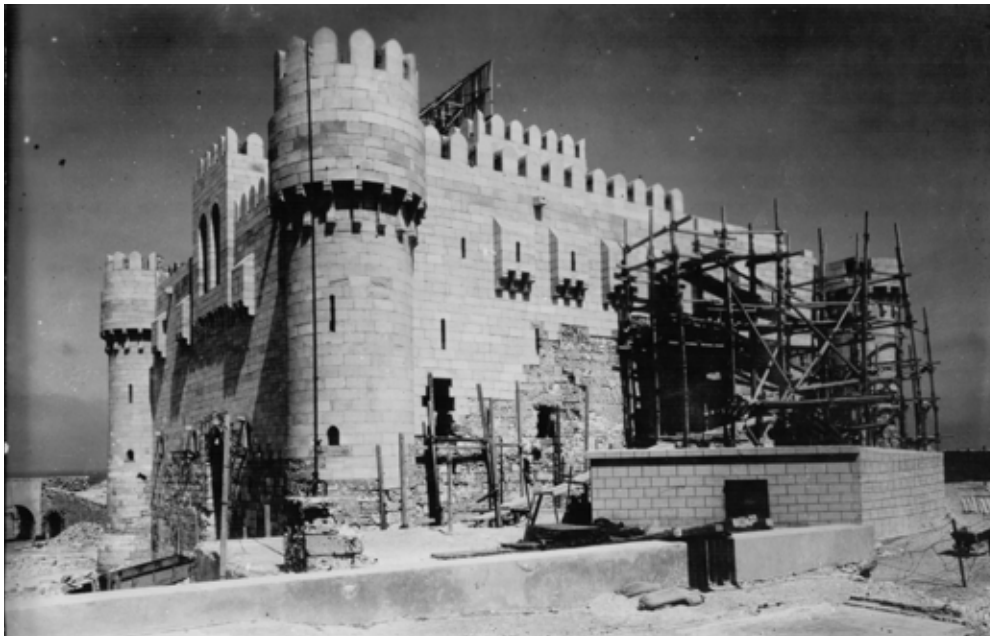
Abb. 256. Hauptturm: Ostfassade nach dem Wiederaufbau, 1941 (SCA).
