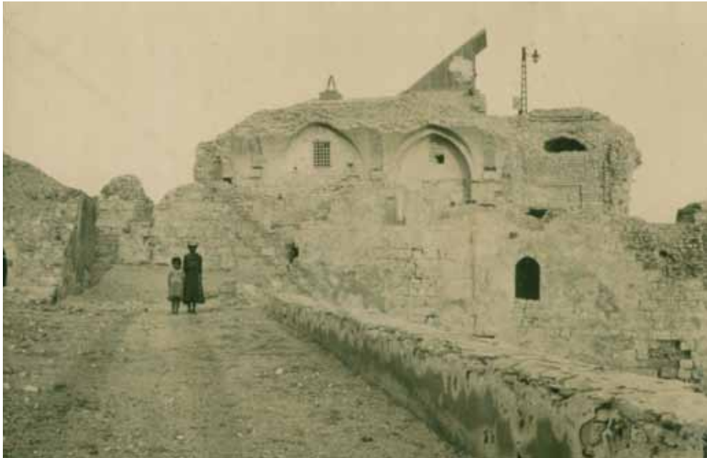
Abb. 244. Hauptturm: Westfassade, 1904 (SCA).
