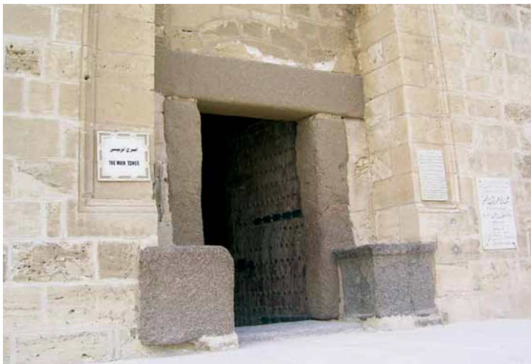
Abb. 293. Die Eingangstür mit den wiederverwendeten Blöcken aus Rosengranit.
