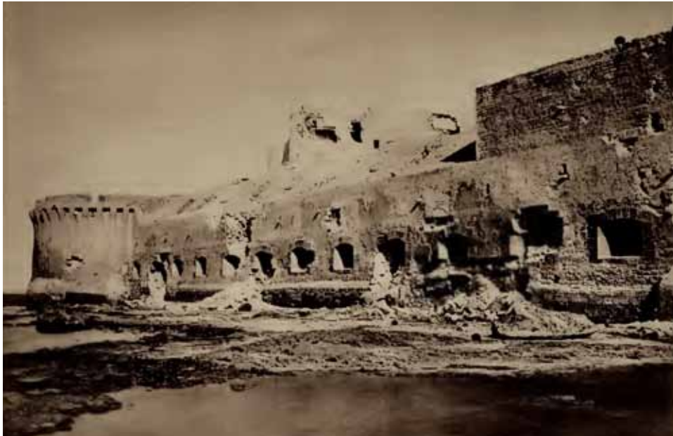
Abb. 137. Die zerstörte Nordmauer, 1882 (GOODRICH 1883, Taf. 4).
