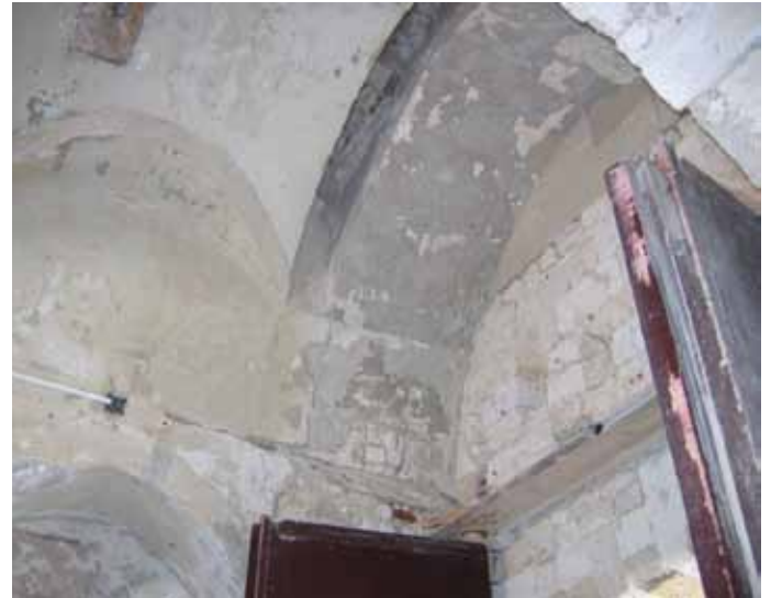
Abb. 74. Maschikuli hinter dem Eingangportal.
