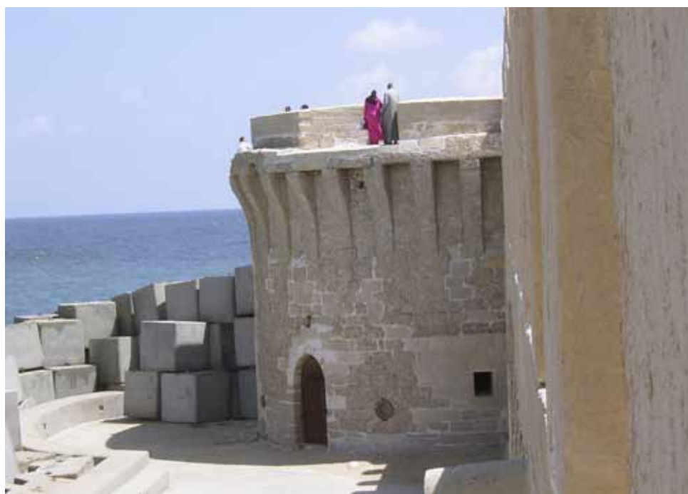
Abb. 136. Geschützturm an der Nordmauer.
