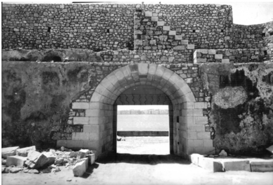
Abb. 153. Südliche Vormauer: Eingangstor, 1949 (SCA).
