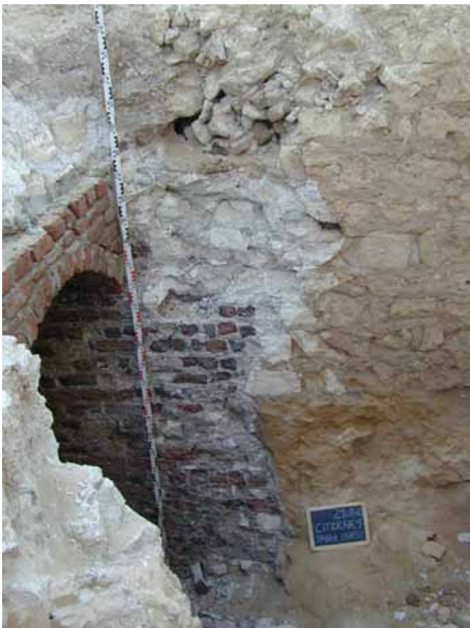
Abb. 211. Zisterne 1: durchschnittene westliche Längswand mit modernem Treppeneingang, 2002.
