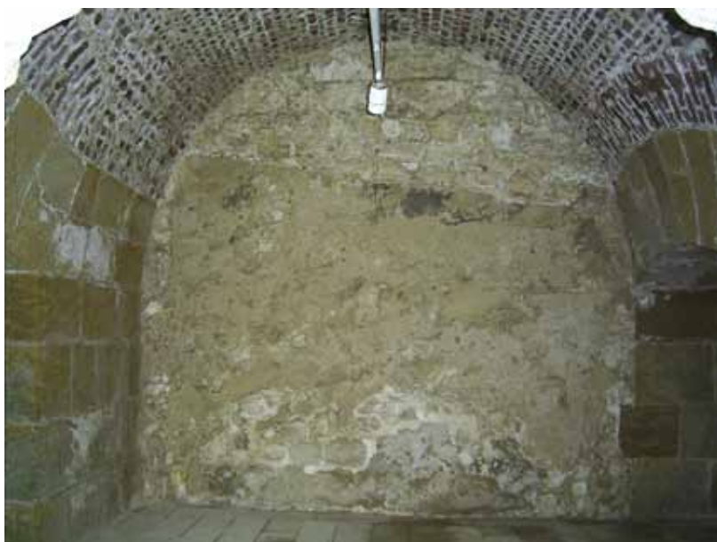
Abb. 173. Kasematten: Artilleriekammer, Rückwand mit Fels.
