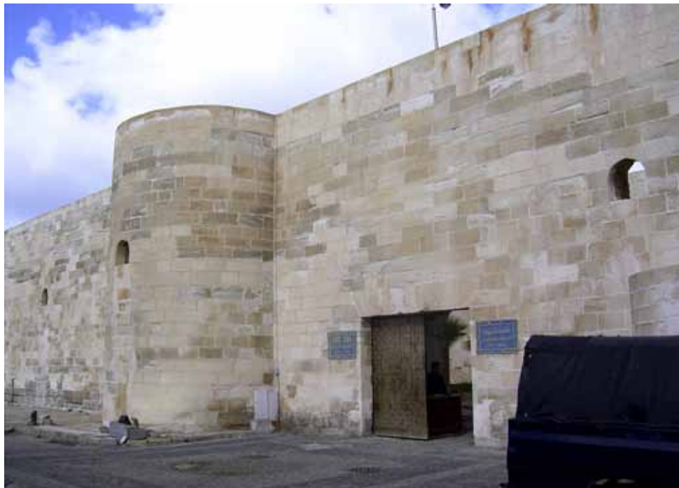
Abb. 129. Heutiges Eingangsportal in der Südmauer.
