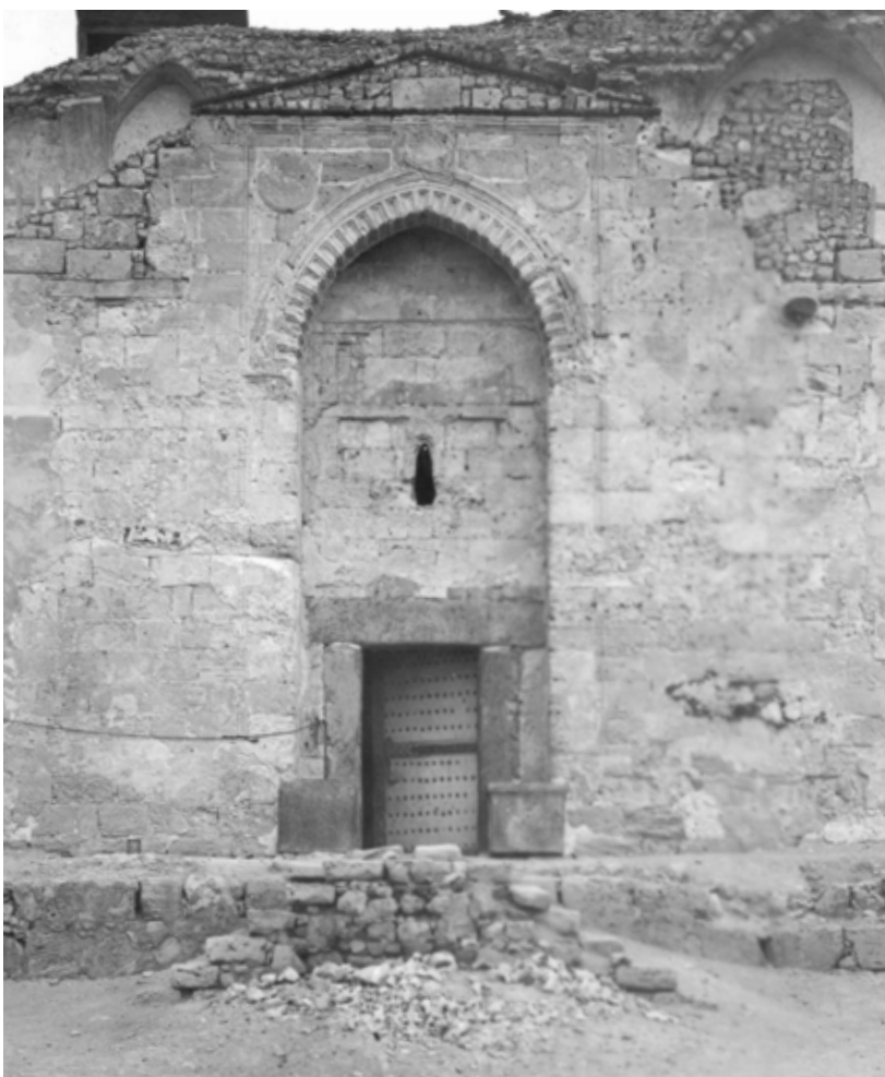
Abb. 296. Das Eingangsportal nach dem Teilabriss 1904 (SCA).
