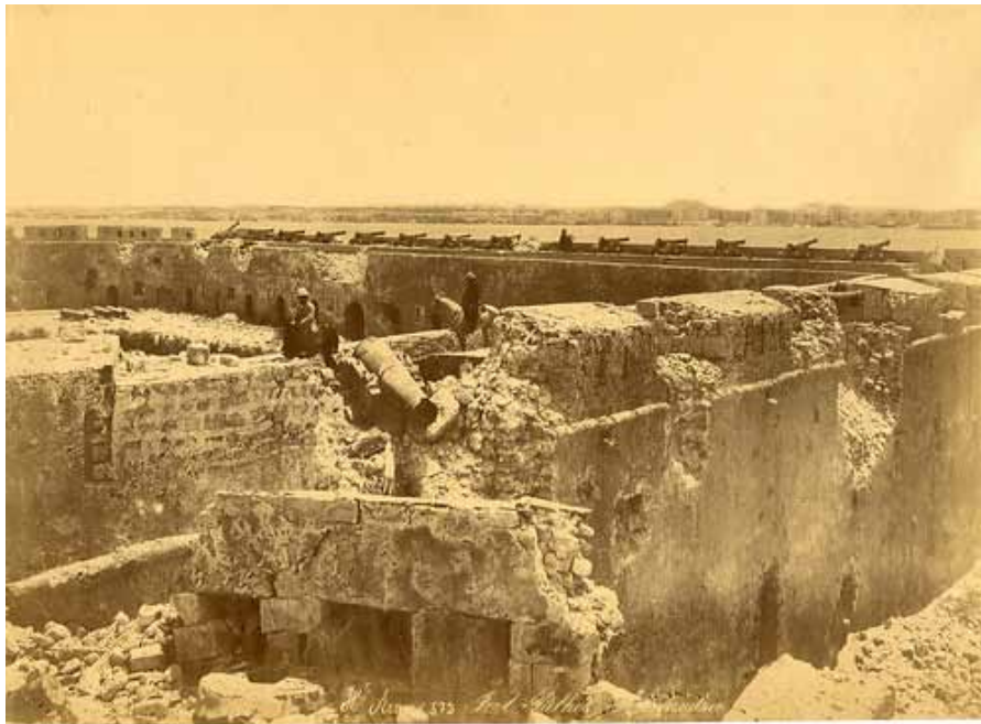
Abb. 181. Westliche Geschützplattform: Blick nach Südosten, um 1882.
