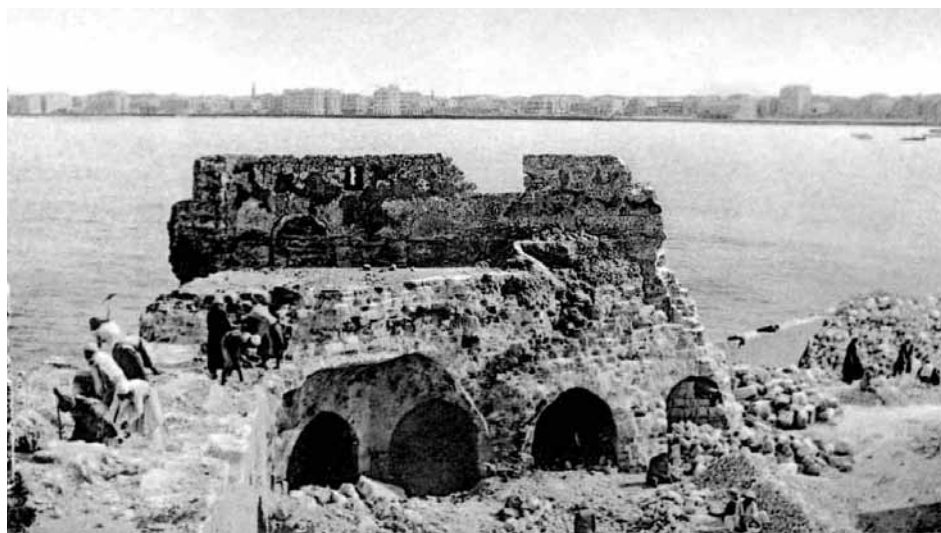
Abb. 168. Östliche Vormauer während des Abrisses (JONDET 1916, Abb. I).
