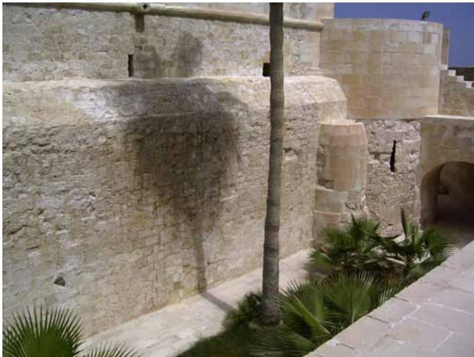
Abb. 160. Südliche Hauptmauer: östlicher Abschnitt.
