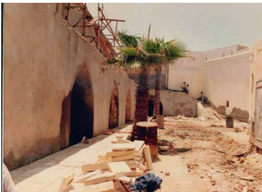
Abb. 157. Südlicher Zwinger: Blick nach Westen, Restaurierung 1984 (SCA).
