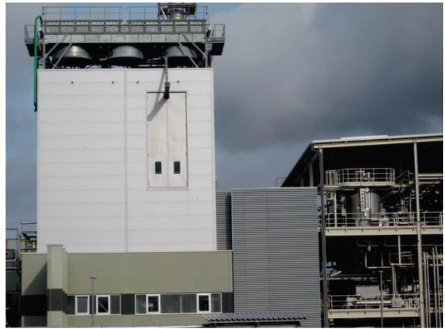
Abb. 15: Luftkühler Anlagenkühlwasser auf dem Vergaser-Turm (Niederdruck, 3-stufig, 1690 kW thermischer Leistung)
