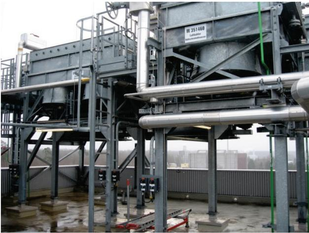
Abb. 14: Luftkühler Kühlschirmkühlwasser (Hochdruck, 1-stufig, 1000 kW thermischer Leistung) und Luftkühler Rohsynthesegas (Hochdruck, 2-stufig, 670 kW thermischer Leistung)
