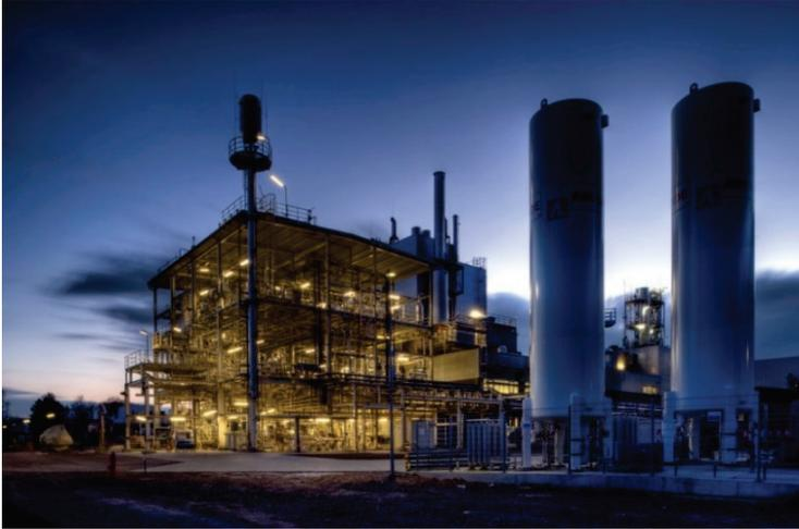
Abb. 10: Pilotanlage bioliq®; rechts N<sub>2</sub>- und O<sub>2</sub>-Hochdruckbehälter, links Kraftstoffsynthese
