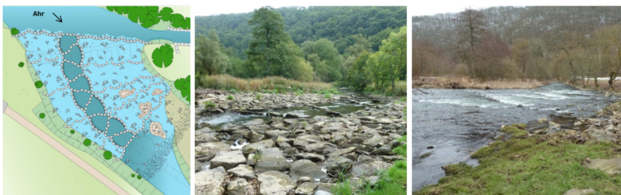
Abbildung 5-9 Sohlgleite an der Ahr: Schematischer Lageplan für den Planungszustand [IB Gebler 2009] (links); Ansicht von oberstrom bei den Durchflüssen Q < 0,40 \text{ m}^3/\text{s} (Mitte) und Q \approx 3,30 \text{ m}^3/\text{s} (rechts) [Dichgans 2013]
