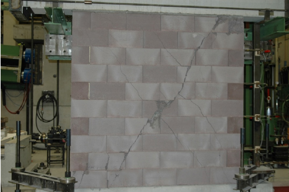
Abb. 4-12 Trennriss bei Wand 2
