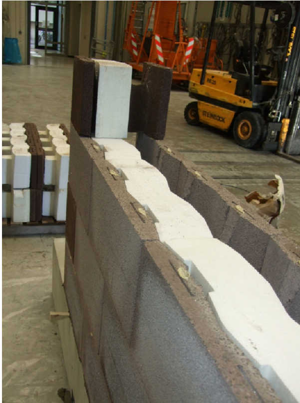
Abb. 4-2 Trockenes Aufmauern der Wände im Halbverband nach abZ
