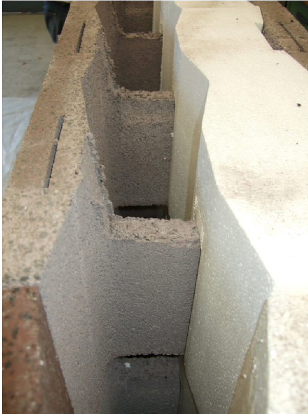
Abb. 4-10 Entfernung der Polystyrol-Stegummantelung
