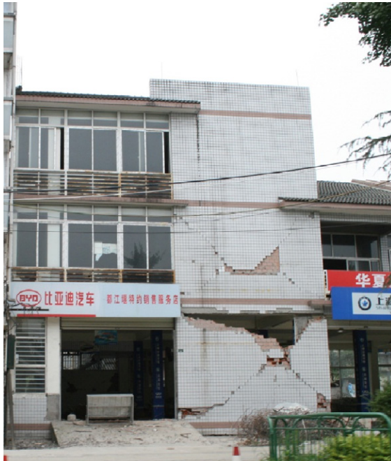
Abb. 2-1 Schubversagen in der Ebene von Mauerwerkswänden [USGS]
