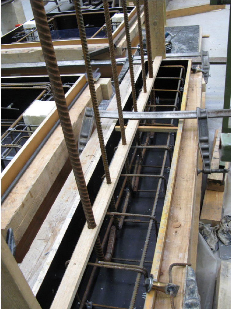
Abb. 4-36 Schalung und Bewehrung von Stahlbetonsohlbalken und Wand
