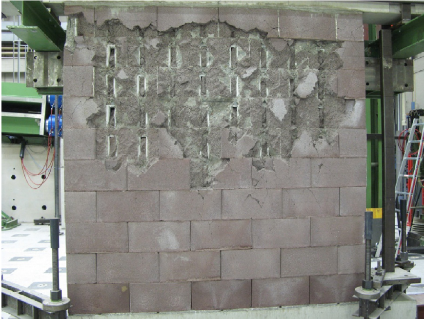
Abb. 4-23 Schädigung der Leichtbetonaußenschale
