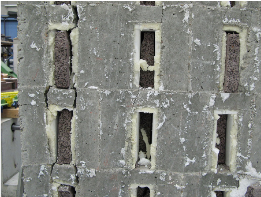
Abb. 4–17 Nahaufnahme des linken Wandbereichs von Wand 3
