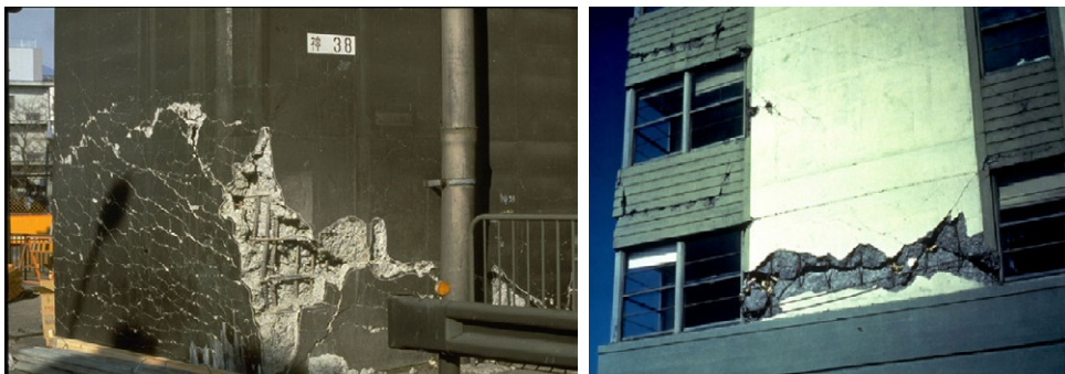
Abb. 2-3 Biegeversagen am Beispiel von Stahlbetonwänden [NISEE a]
