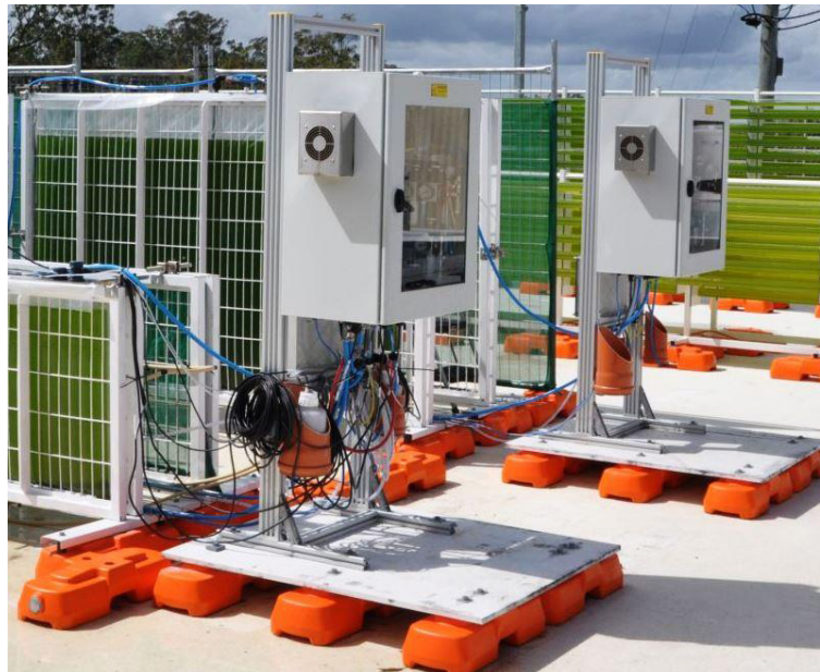
Abbildung 4.9 Control-Units am Solar Biofuels Research Centre (SBRC), Australien. Foto: Florian Oswald
