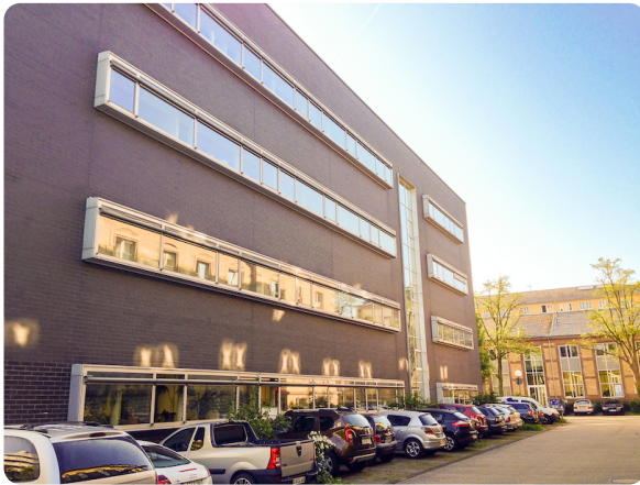
(a) Gebäude vom Boden aus aufgenommen.
