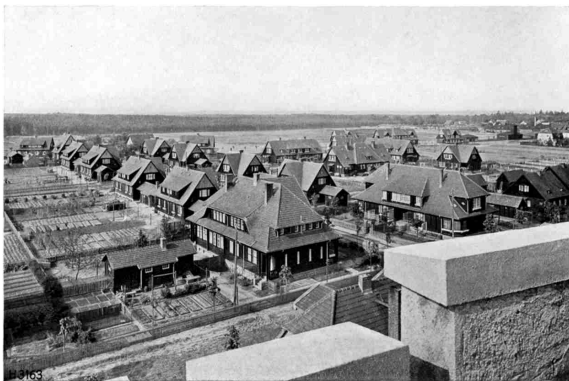
Abbildung 5.2.100: Holzhauskolonie Neu-Ödernitz in Niesky. Im Vordergrund das Doppelwohnhaus Christophstraße 11/13 in Niesky. Ausführung: Christoph & Unmack A.-G., Niesky. Quelle: Christoph & Unmack A.-G.: Deutsche Holzhäuser, Firmenkatalog 23, Niesky ohne Jahr, S. 41.
