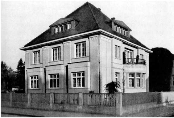
Abbildung 6.2.16: Haus Brink, Darmstadt 1912. Architekt: Albinmüller. Quelle: Albinmüller: Werke der Darmstädter Ausstellung 1914 und andere Arbeiten nach Entwürfen von Professor Albinmüller. Jubiläumsausgabe 1917, Magdeburg 1917, S. 74.
