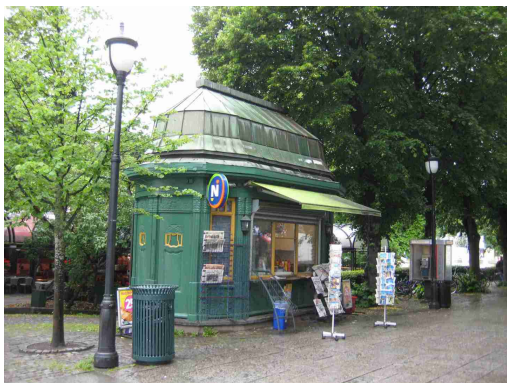
Abbildung 5.1.18: Kiosk. Karl Johans gate, Oslo, Norwegen 2011. Foto: Deist, Jörg.
