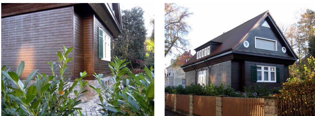
Abbildung 5.4.13: Das bürgerliche Wohnhaus 1928, Rothenbacher Kirchsteig 1, Glauchau. West-Ansichten. Architekt: Albinmüller, Christoph & Unmack A.-G.. Glauchau 2012. Foto: Deist, Jörg.
