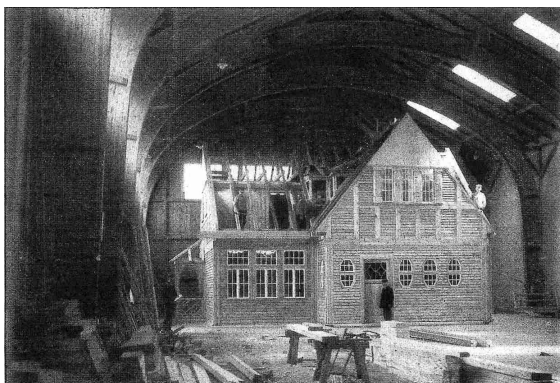
Abbildung 2.3.88: Christoph & Unmack A.-G., Niesky. Probe-Montage eines Holzhauses in der Montage-Halle. Quelle: Der Holzbau. Mitteilungen des „Deutschen Holzbau-Vereins“. Herausgegeben von der „Deut-schen Bauzeitung“. Verlag Deutsche Bauzeitung G. m. b. H., Berlin Jahrgang 1921, Nr. 11, S. 42.
