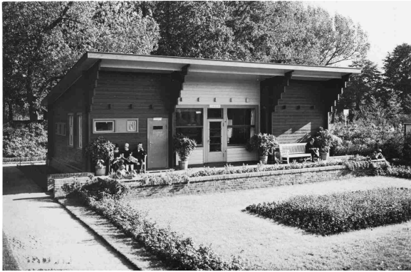
Abbildung 2.3.53: Mittelstandshaus auf der Deutschen Gartenbau- und Schlesischen Gewerbe-Ausstellung in Liegnitz (GUGALI) 1927. Ausstellungsbau Nummer 42. Architekt: Moritz Hadda. Ausführung: Christoph & Unmack A.-G.. Sondergarten: C. Berndt-Zirlav. Foto: Architekturmuseum der Technischen Universität Berlin in der Universitätsbibliothek, Inv. Nr. F 11021.
