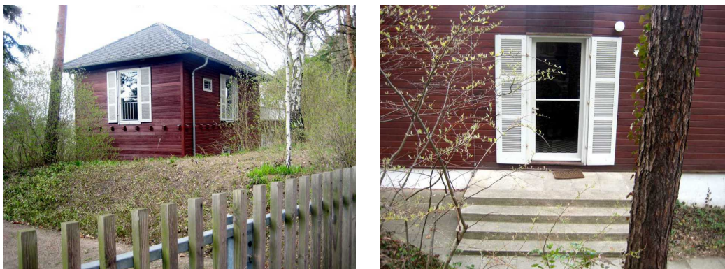
Abbildung 2.3.64: Das Holzhaus von Albert Einstein. Außenansicht und Eingangssituation. Architekt: Konrad Wachsmann. Caputh 2012. Foto: Deist, Jörg.
