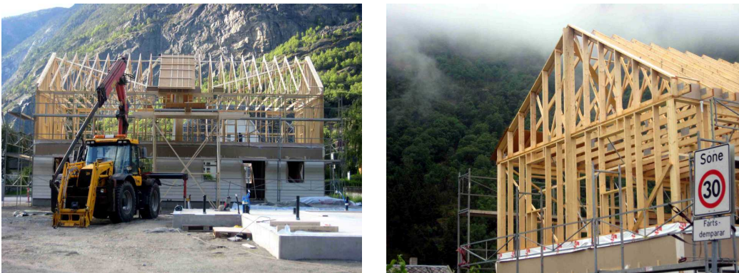
Abbildung 2.2.14: Holzhaus in der modernen norwegischen Fachwerkbauweise. Montage eines Wohnhauses. Lærdalsøyri, Norwegen 2011. Foto: Deist, Jörg.
