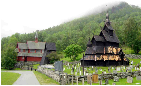
Abbildung 3.5.20: Stabkirche Borgund. Neubau (links), freistehender Glockenturm und Altbau (rechts). Borgund, Norwegen 2011. Foto: Deist, Jörg.
