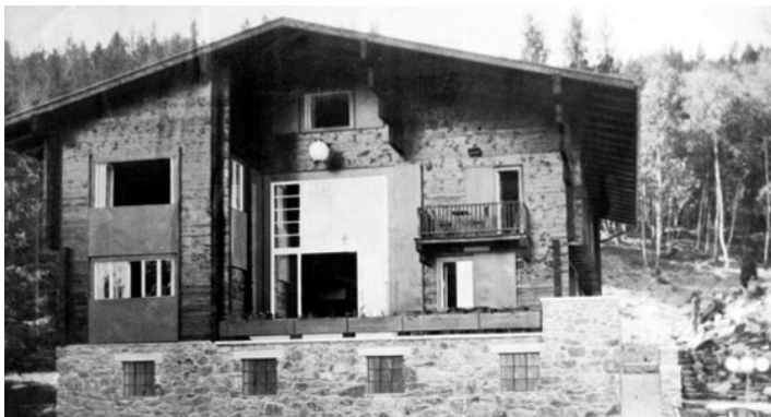
Abbildung 2.3.12: Holzhaus in Blockbauweise. Landhaus Khuner in Payerbach, Österreich, 1930. Architekt: Adolf Loos. Quelle: Hotel-Restaurant Looshaus. Familie Steiner, Kreuzberg 60, 2650 Payerbach, Österreich. http://www.looshaus.at
