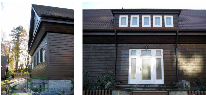
Abbildung 5.4.12: Das bürgerliche Wohnhaus 1928, Rothenbacher Kirchsteig 1, Glauchau. Nordwest-Ansichten. Architekt: Albinmüller, Christoph & Unmack A.-G.. Glauchau 2012. Foto: Deist, Jörg.
