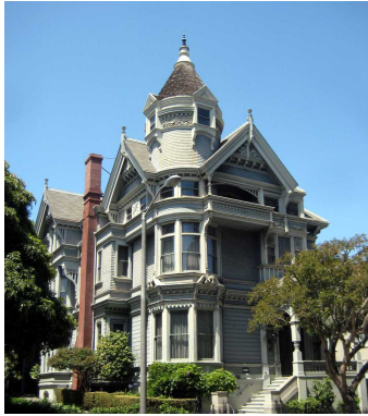
Abbildung 2.2.18: Die amerikanische Holzbauweise. Haas-Lilienthal House, Home of San Francisco Architectural Heritage, errichtet 1886. Architekt: Peter Richard Schmidt (1833-1901). Franklin Street, San Francisco, California, USA 2015. Foto: Deist, Jörg.
