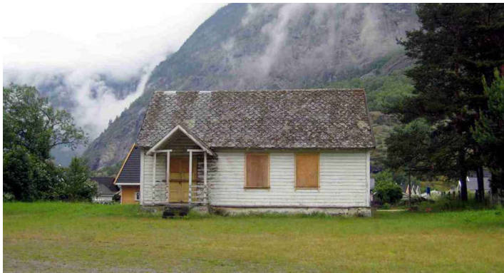
Abbildung 5.2.34: „Losjehuset“, Wohnhaus, erbaut 1906, abgebrannt 2014. Gamle Lærdalsøyri, Norwegen 2011. Foto: Deist, Jörg.
