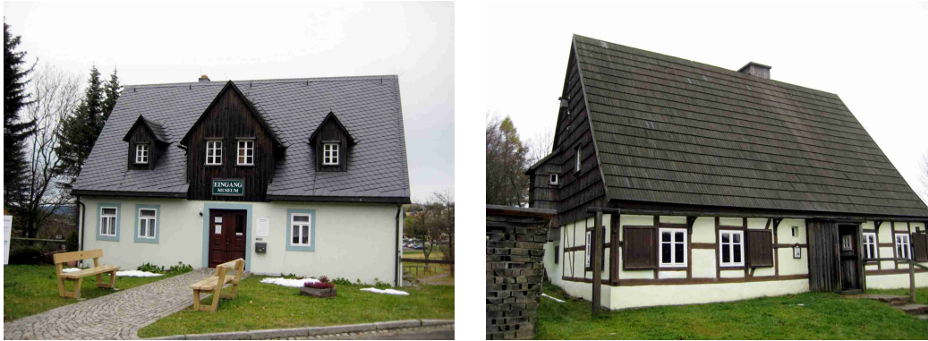
Abbildung 5.2.110: Erzgebirgisches Freilichtmuseum Seiffen. Eingangshaus, Zugang zum Freilichtmuseum, Seiffen 2012 (links). Foto: Deist, Jörg. Spielzeugmacherhaus, Seiffen 2012 (rechts). Foto: Deist, Jörg.
