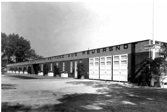
Abbildung 5.3.49: Zwei zerlegbare Baracken für die Feuerwehr, Deutsche Theater-Ausstellung, Magdeburg 1927. Süd-Ansicht. Architekt: Albinmüller. Foto: Hatzold, Rudolf. Quelle: Nachlass Geschäftsführung Deutsche Theater-Ausstellung Magdeburg 1927 und Forum Gestaltung Magdeburg. Vgl. Albinmüller: Neuere Arbeiten von Prof. Albinmüller. Neue Werkkunst, Berlin 1928, S. 13.
