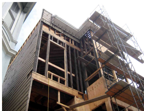
Abbildung 2.2.20: Die amerikanische Holzbauweise. Sanierung eines Wohnhauses. Architekt: Jensen Architects. General Contractor: Drömhus. Fulton Street, Alamo Square, San Francisco, California, USA 2015. Foto: Deist, Jörg.
