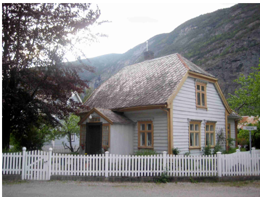
Abbildung 5.2.43: Holzhaus, Wohnhaus. Gamle Lærdalsøyri, Norwegen 2011. Foto: Deist, Jörg.
