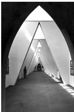
Abbildung 5.3.31: Einbau Kojenwände, Deutsche Theater-Ausstellung, Magdeburg 1927. Halle I (Historische Abteilung, Kultur- und Künstlerische Abteilung). Architekt: Albinmüller. Foto: Hatzold, Rudolf. Quelle: Nachlass Geschäftsführung Deutsche Theater-Ausstellung Magdeburg 1927 und Forum Gestaltung Magdeburg.
