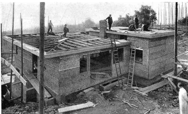
Abbildung 2.3.105: Haus 22, Holzgerippekonstruktion. Architekt: Richard Döcker. Quelle: Deutscher Werkbund: Bau und Wohnung. Die Bauten der Weißenhofsiedlung in Stuttgart errichtet 1927 nach Vorschlägen des Deutschen Werkbundes im Auftrag der Stadt Stuttgart und im Rahmen der Werkbundaussstellung „Die Wohnung“, Stuttgart 1927, S. 44, 46.
