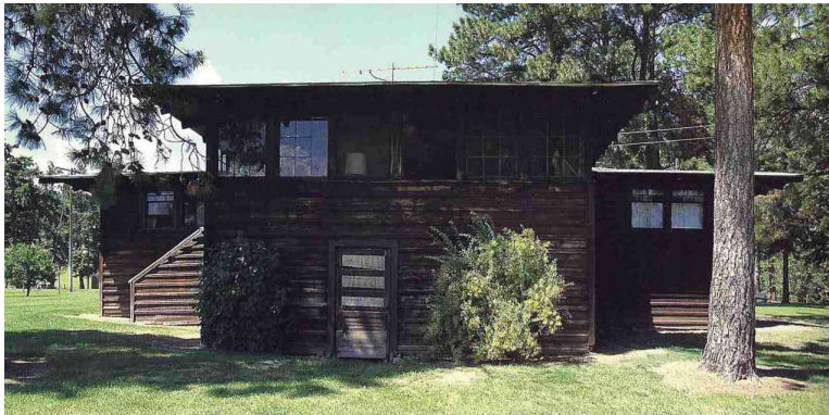
Abbildung 2.3.39: Como Orchards Summer Colony, Darby, Montana 1909. Architekt: Frank Lloyd Wright, 1909. Foto: Zimmerman, Scot. Quelle: Legler, Dixie: Frank Lloyd Wright, the Western Work, San Francisco 1999, S. 14.
