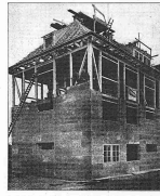
Heraklith-Bauweise im Heraklith-Bauweise in Dessau
