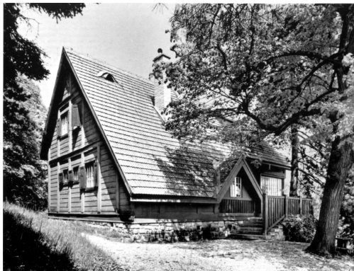
Abbildung 5.2.21: Transportables Jagdhaus für Alexander Pazzani in Klosterneuburg-Weidling, Wolfsgraben 1910. Architekt: Josef Hoffmann. Quelle: Sekler, Eduard F.: Josef Hoffmann. Das architektonische Werk; Monographie und Werkverzeichnis, 2. überarbeitete Auflage, Salzburg, Wien 1986. S. 329.
